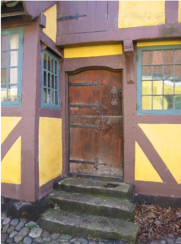
Dør i 'Priors Hus' i Ærøskøbing, angiveligt fra 1690 og malet med blodfarve – men kun én gang. Her er der tale om 'vedvarende brug', men også om 'genanvendelse', fordi døren ikke er kasseret.
