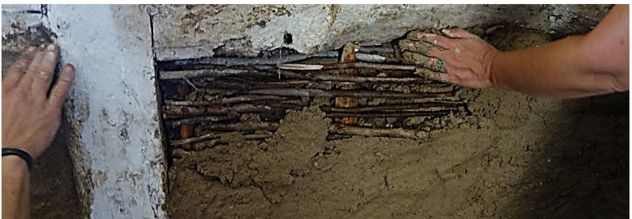
Lerklining af bindingsværk på hassel-kæppe
