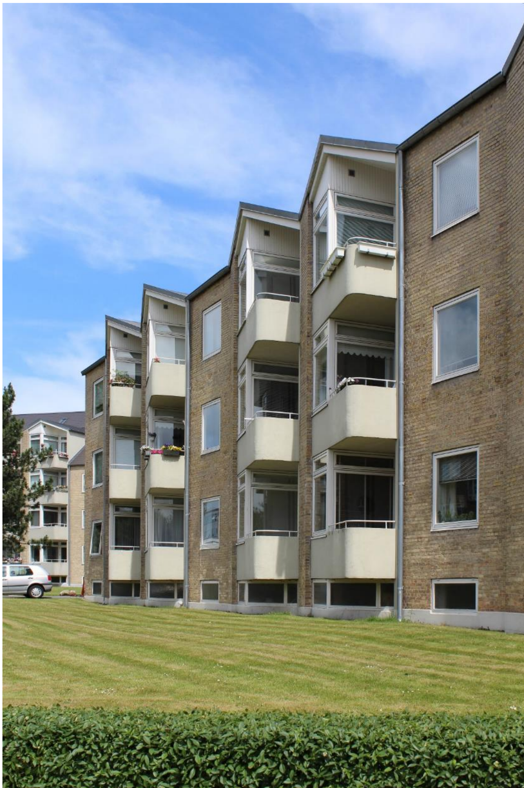
Arne Jacobsen, Allehusene, Jægersborg Alle i Gentofte opført i 1949 – 53.
