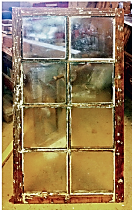
Vådafskrabning uden varme. Linolien blødgør og løsner de gamle, løse malingslag. Herefter skrubes der med en hårdmetalskraber.
