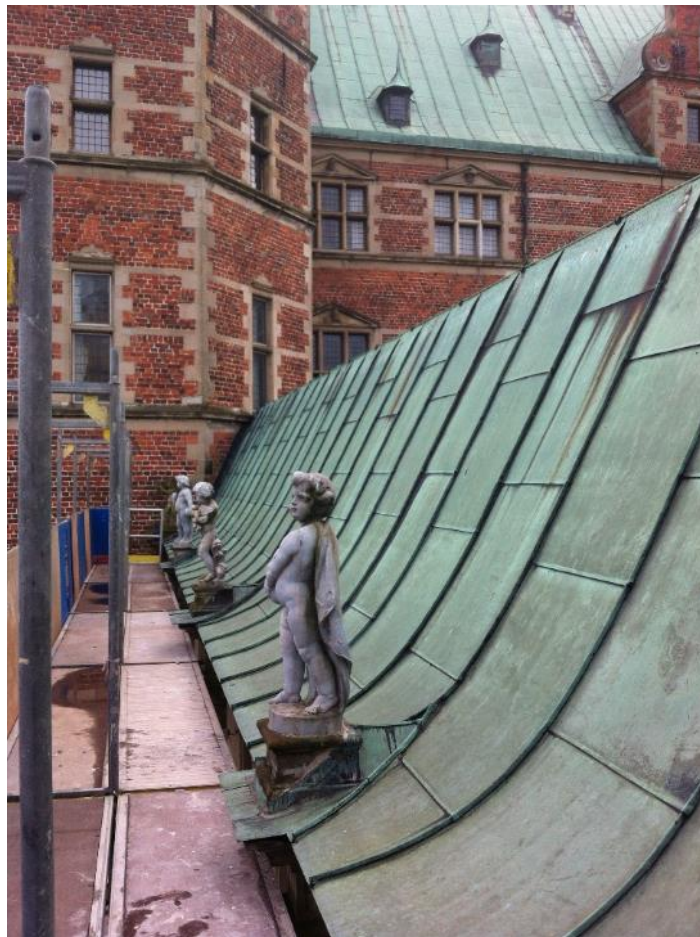
Et af de meget stejle 'Renæssancetage' i Danmark. Her Frederiksborg slot. Man kan ligefrem se, hvordan opskalkningen ved tagfoden får vandstrømmen ned ad taget, til at bremse op.
