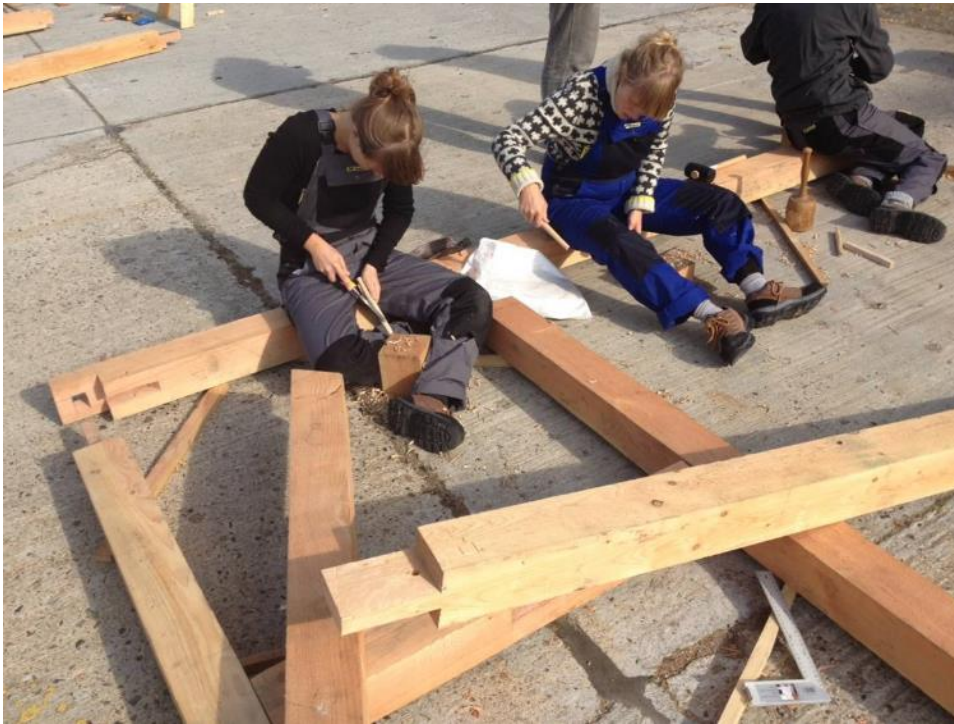
Tømmerkonstruktionen til en 'Haugbarg', bygget af studerende på Arkitektskolen i 2012 som led i et forskningsprojekt på kandidatprogram i 'Kulturarv, Transformation og Restaurering'. Se også side 43.
