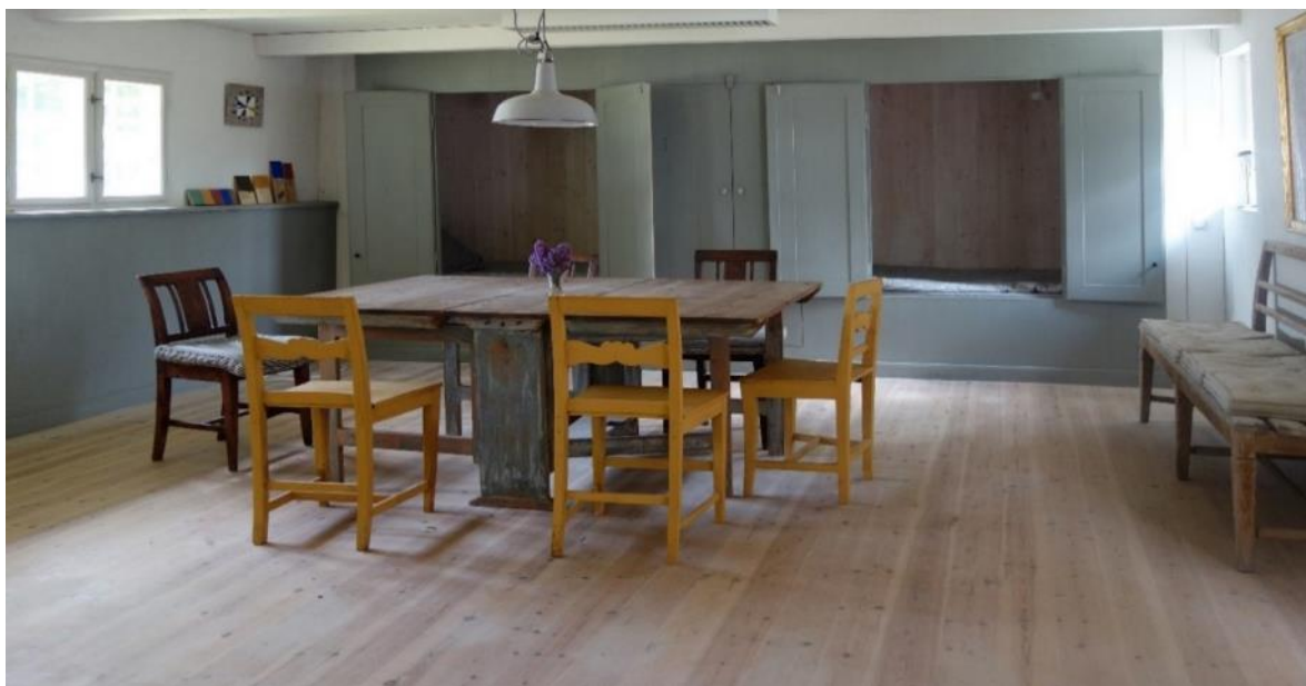
En ny 'sal', der er indrettet i den tidligere svinesti i den ene ende af stuehuset. Et helt nyt og moderne rum, men udført og indrettet med de klassiske byggematerialer, konstruktioner og håndværksmetoder. Bl.a. linoliemaling, limfarve, sæbeskurede trægulve, forsatsvinduer. De gule stole er også male med limfarve.
