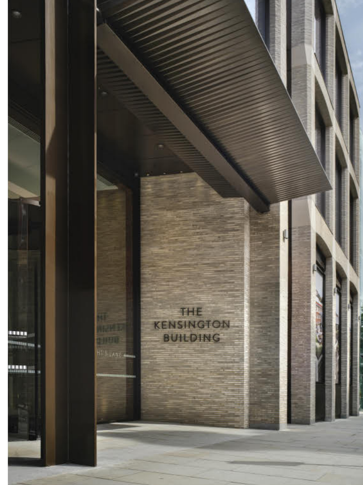
Die 5,6 Meter hohe Decke verleiht der Lobby ein Gefühl der Offenheit zur Straße hin. Die tiefen Fenster betonen die mit Ziegeln verkleideten Stützen und erzeugen in der Fassade einen Schatteneffekt.
