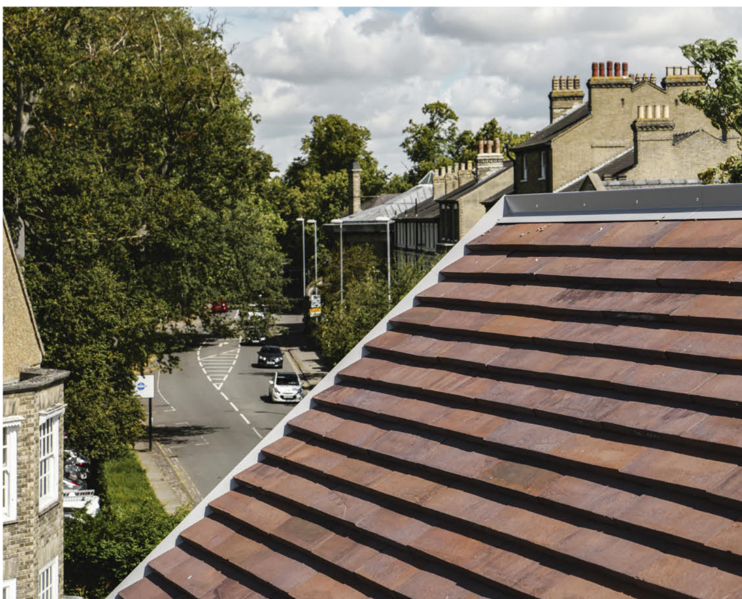
Mødet mellem henholdsvis tagets Coverbeklædning og gavl og de Coverbklædte facaders møde om et hjørne kan detaljeres på en række forskellige måder. MCW Architects valgte i begge tilfælde at lade Coverstenene løbe vinkelret ind på et aluminiumsprofil. Tagets kip afsluttes ligeledes med en aluminiumsinddækning.
