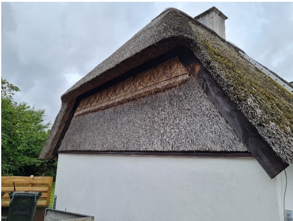
Fig 14. Eksempel på hvorledes dukker, resecer og kæppe kan anvendes til ornamentering. Foto: Ruud Conijn, 2021.
