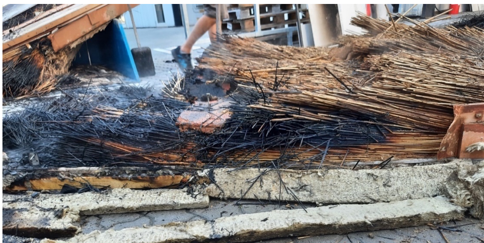
Figur 19. Undersøgelse af lerpladens beskyttende virkning. En af lerpladerne er blotlagt og intakt
