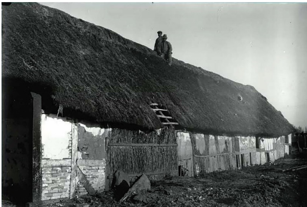
Fig 3. Lundagergården før nedtagning. Strå slået op på væggen for at beskytte tavl (Nationalmuseets Samlinger/ Halvor Zangenberg 1925)
