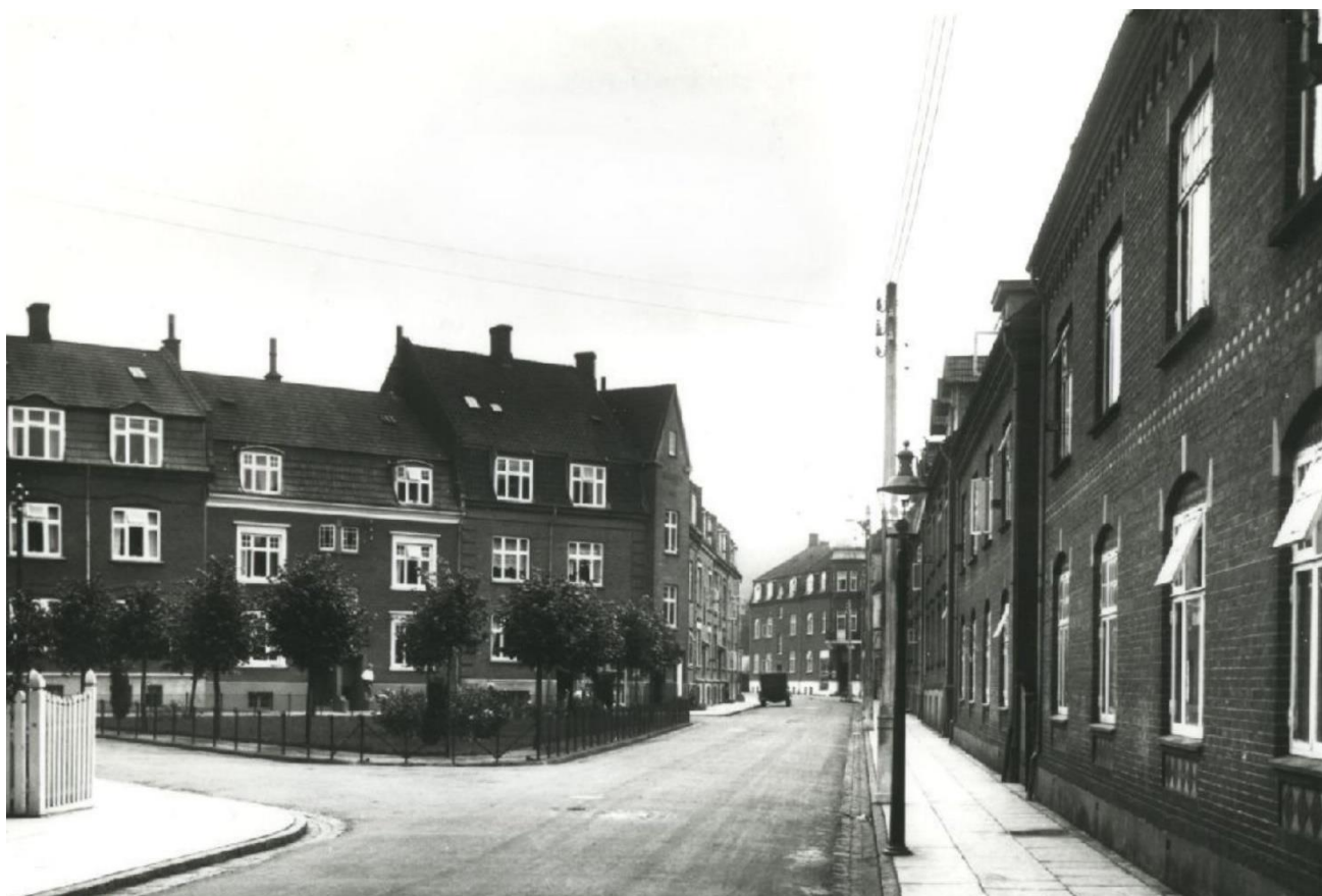
Ågade - 'Trekanten'. I dag er der en bunker. Fotograf: Ukendt. Foto: Vejle Stadsarkiv
