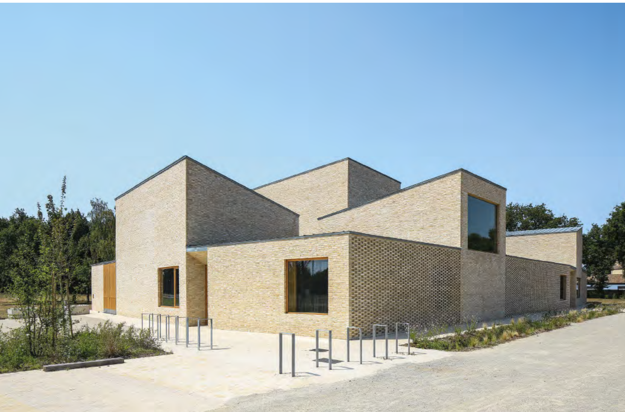
Hellgelbe Ziegel sowie Türen und Fensterrahmen aus goldener Eiche verleihen dem Gebäude einen warmen und einladenden Charakter. Unterschiedliche Raumhöhen, Dachneigungen und Mauerwerkstypen sorgen für Abwechslung und spannende Licht- und Schattenspiele. Foto: Paul Kozlowski
