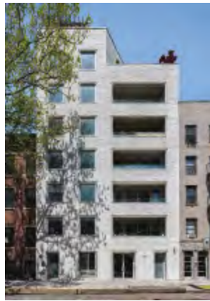
10 355 East 19th Street, Manhattan Arkitekt: Issac & Stern Architects Færdiggjort: 2016 Sten: K11 Foto: Dean Kaufman
