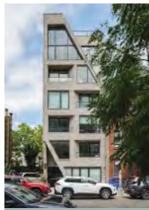
16 141 Green Street, Brooklyn Architekt: INOA Architecture Fertiggestellt: 2018 Ziegel: K91 Foto: Florian Holzherr
