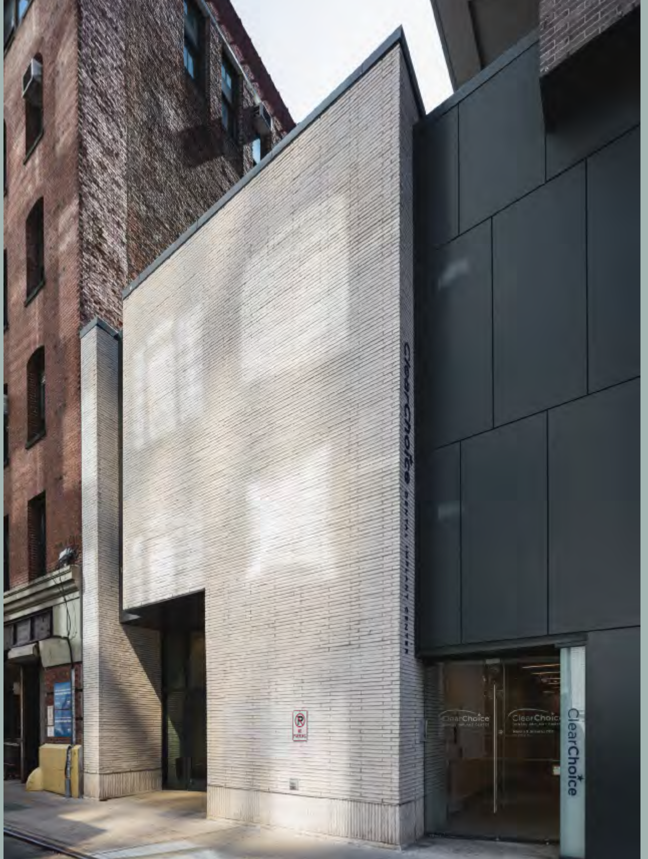
Der hohe Wohnturm und das Eingangsgebäude mit den klaren Konturen sind durch das schwarz lackierte Stahlprofil optisch getrennt. Für den Eingang haben die Architekten den fast weißen K11 in einem Viertelstein-Blockverband gewählt. Der Verband wird durch die Farbe der Fuge betont, die etwas dunkler ist als der Stein. Das Gebäude wird zum Boden hin durch einen Verblendsturz abgeschlossen.
