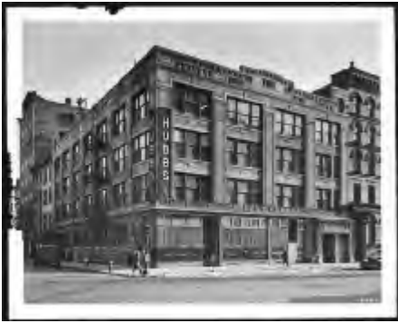
Teil dieses Projekts war die Restaurierung und der Umbau eines Industriegebäudes von 1916.
