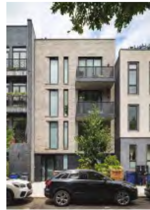
11 83 Eagle Street, Brooklyn Arkitekt: StudioSC Færdiggjort: 2021 Sten: K91, K92 Foto: Florian Holzherr
