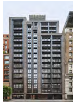
02 210 West 77th Street, Manhattan Arkitekt: Thomas Juul-Hansen Færdiggjort: 2017 Sten: K54 Foto: Dean Kaufman Se omtale side 3
