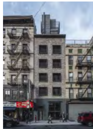
21 120 Allen Street, Manhattan Arkitekt: Grzywinski+Pons Færdiggjort: 2016 Sten: D81 DNF Foto: Nicholas Worley Se Petersen magasin nr. 40
