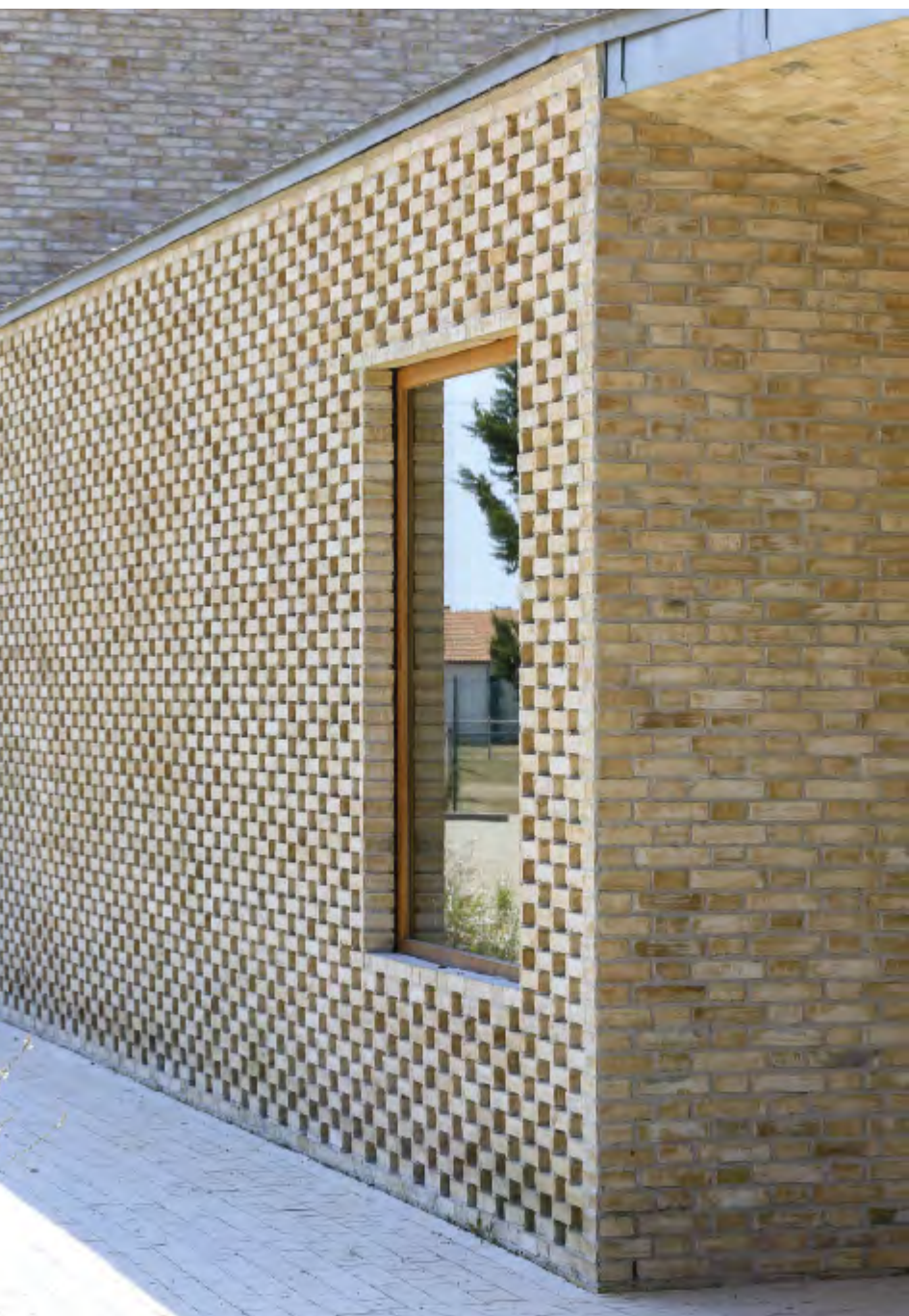
Facaderne er muret på tre forskellige måder. Dels i lukket flamsk forbandt, dels som reliefmurværk og dels som såkaldt mashrabiya, et gitterværk til ventilation efter arabisk forbillede. Facadens murværk er ført til terræn.
