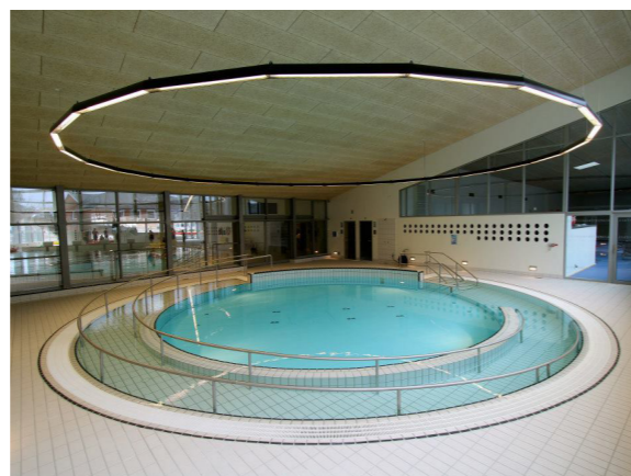
Figure 6.1-27 Vandhalla: linear circular lighting element over the round pool (© Stevie Kørvell - Egmont Højskolen)
