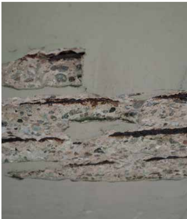
Kalkaflejring på betonbjælke. Foto: Christina Särs Vernersen
