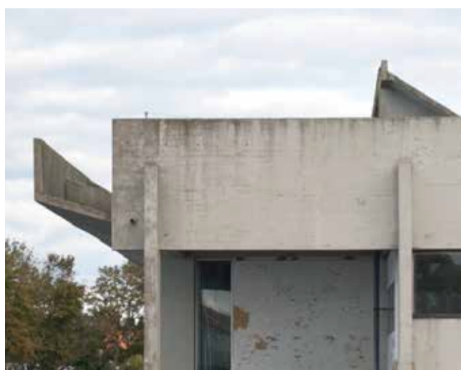
Ovenlys og udgraving på den nordvendte facade. Foto: Christina Sørs Vernersen
