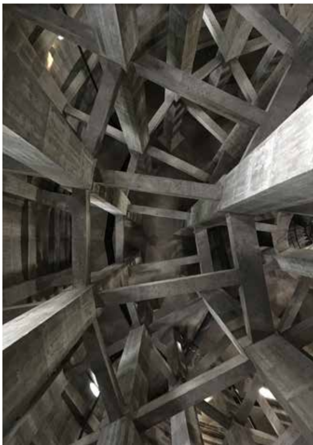
Søjlebjelke-konstruktionen set oppe fra en rist i tekniketagens gulv. Til højre i billedet anes den lange valsedede ståltrappe. Foto: Laust Øby
