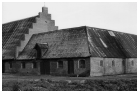
Et udvendigt hjørne - der er bølgeeternit på tagfladerne til venstre og pandeplader til højre
