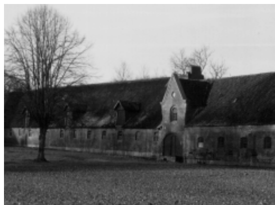
I gårdsrummene ses to dominerende tagmaterialer - tegl omkring borggården, staldgården og en del af ladegården - og bølgeeternit i den resterende del af ladegården
