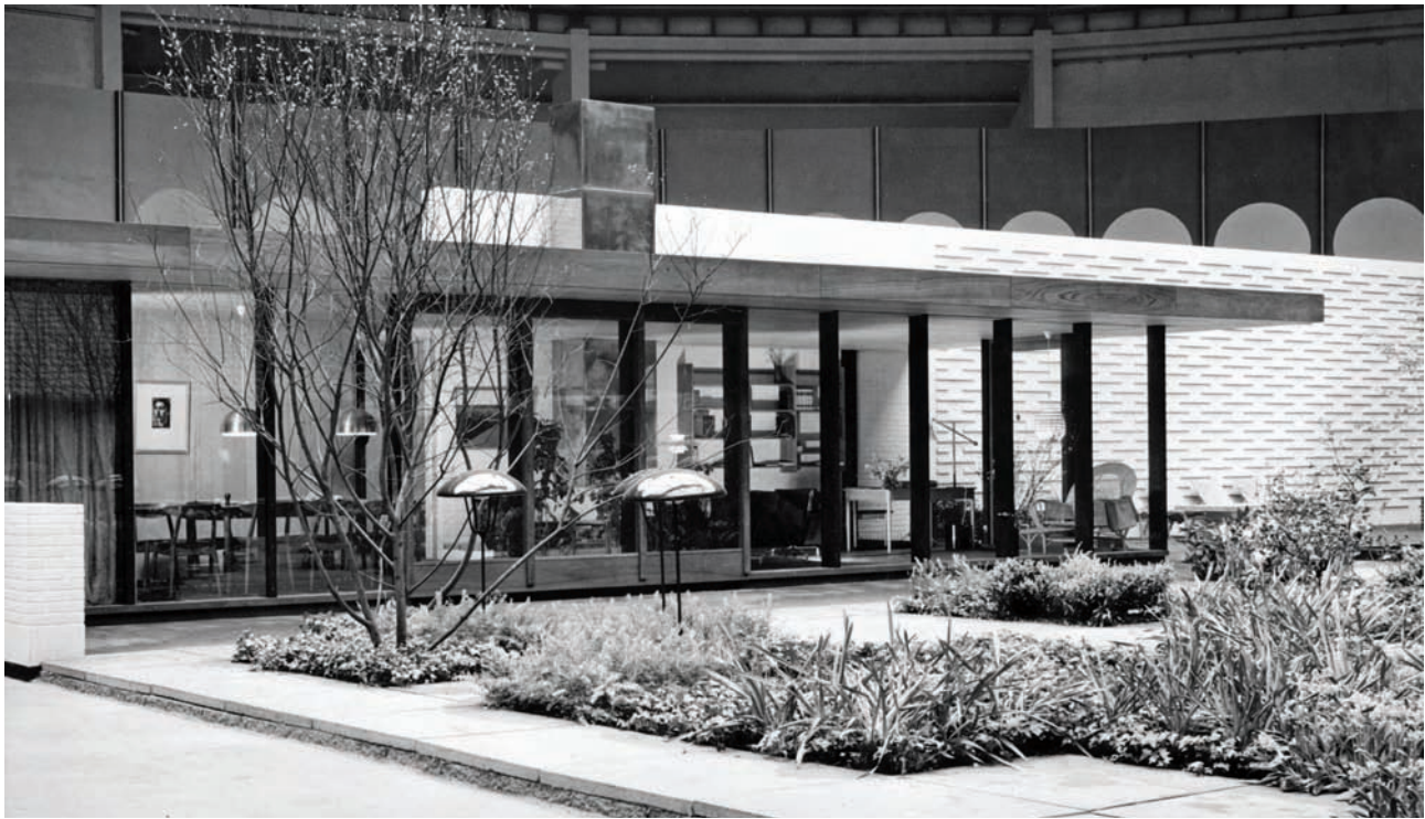
3.17 Jørgen Bo, Vilhelm Wohlert and Ole Nørsgaard, The Dream House, Huset i haven , Copenhagen, 1959.
