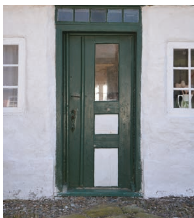
Tidligere fløjdør, formodentlig fra stuehusets sydfacade, er blevet genanvendt mod gårdsrummet.
