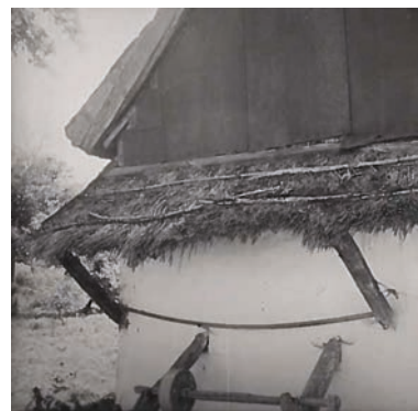
Detalje af vestgavlens halmmåltag. Foto Holger Rasmussen. NEU negativ nr. 19.947.
