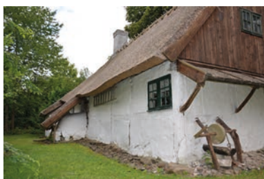
Facadernes hierarki. Sydfacaden er den primære facade mod landsbygaden. Det er let at aflæse, hvad der er bolig og udhus. Nordfacaden er mere lukket og funktionel med fremspringende bageovn og lude.
