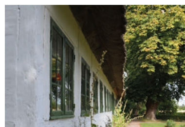
Ligeledes beskytter tagets brede udhæng tavlene mod udvaskning og skærmer desuden huset mod overophedning om sommeren.
