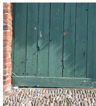
Eksempel på reparation af bygningdele. Her er portens brædder blevet repareret.
