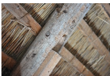
Spærtømmer med spor af tidligere anvendelse. Især ladens tømmer bærer præg af genbrug.
