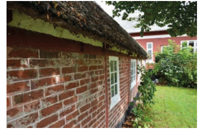
Skolevej 2 er kalket og derefter er fugerne opstreget og sålbænkene påmalet. Det sirligt udførte of-ferlag ses som æstetisk bæredyg-tighed.
