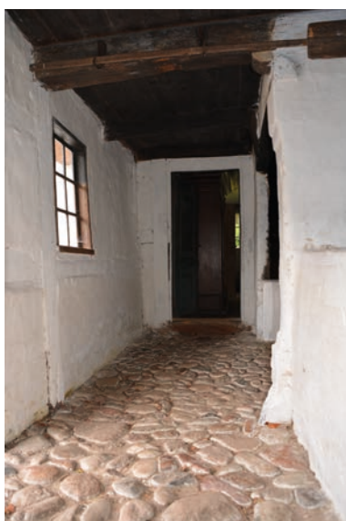
Eksempel på æstetiske hierarkier. Øverst et kik fra mellemstuen til dagligstuen. Der er bræddegulve, malede lofter og på et tidspunkt er stuen blevet tapetseret. Nederst ses bryggerstet med ubehandlet loft, kalkede vægge og pigstengulv.
