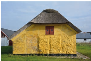
F.eks. er vestgavlens tre sydlige fag udmuret med marksten.
