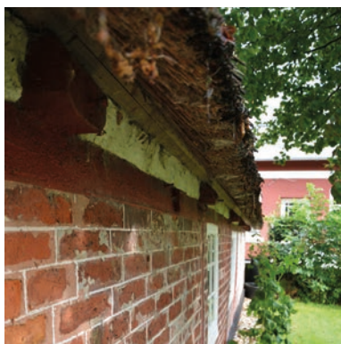
Udhænget beskytter bjælkehovederne.
