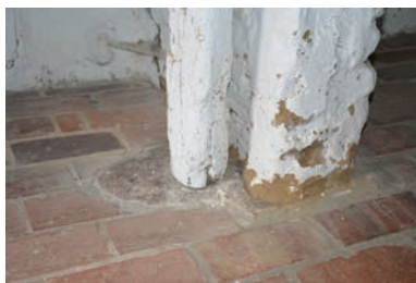
Højremstolpe anbragt på syldsten i bryggerset.
