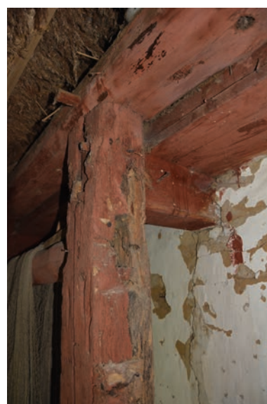
I rummet nord for vesterstuen står højremskonstruktionen frit. Både stolpe og højrem bærer præg af tidligere anvendelse gennem tap- og støjlehuller. Stolpen står som anden stolpe fra vest, men bærer tømmermærke ΔΔΔΔ
