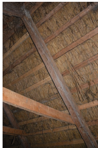
Foto fra østfløjens tagværk på Hans Hansens Gård. Et stykke tagrem - sikkert fra den tidligere bindingsværkslænge - er blevet genanvendt som spær.
