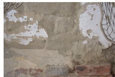
Eksempel på materialekunds- skab. De skrøbelige klægsten er anbragt på en sokkel af brændte sten.
