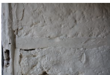
Billede fra tofteporten. Stolpen til venstre er genanvendt, jf. det tomme taphul. Løsholtet er hugget med økse og tavlene klinede.
