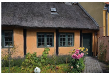
I husets vestlige del ses bindingsværkskonstruktionen stadig.
