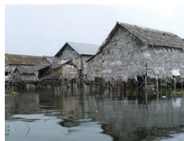
Kampong Phluk, Cambodia. Bebyggelse på pæle. Husene har vægge af palmeblade. Foto Rosa Teira.
