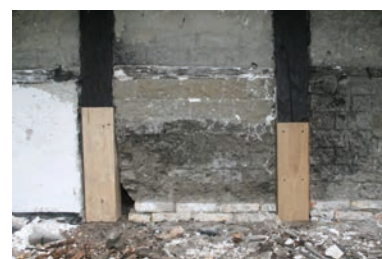
Materialekundskab: de ubrændte lersten står på en sokkel af brændte sten. Foto Søren Kibsgaard.
