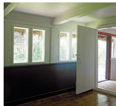
Husets paneler er repareret, suppleret og isoleret. Foto Helene Høyer Mikkelsen for Realdania.
