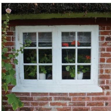
Egnsbyggeskikkens æstetiske detaljer i form af opstregede fuger og påmalede sålbænke.
