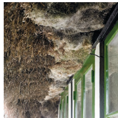
Ved istandsættelsen af tangtaget blev ældre, intakte tanglag bevaret. Foto Helene Høyer Mikkelsen for Realdania.
