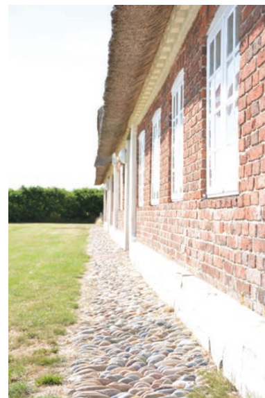
Stuehusets sydfacade. Det brede udhæng skærmer for overophedning om sommeren og beskytter mureværket.
