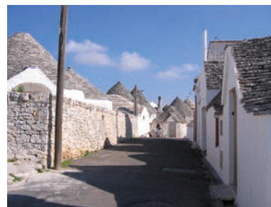
Trullierne i Puglien, her Alberobello, er bl.a. kendetegnet ved kuppelformede tage. De blev oprindeligt opført uden brug af mørtel, så de hurtigt kunne nedtages og flyttes (Oliver 2010: 93).
