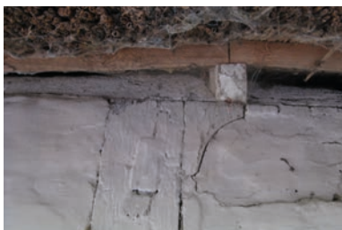
Knægten har båret husets oprindelige østgavl, der var udkraget for at beskytte de lerklinede tavler. Over knægten ses en skalk.
