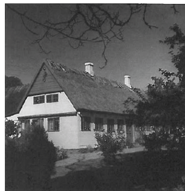
Marie Hansens gård i Keldby Sogn. Stuehuset på denne gård har også helgavl, hvor spidsen er lukket med vandret bræddetbeklædning. Et vandbræt beskytter de nederste tavler. NEU negativ nr. 22416.
