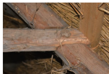
Hanebåndet er bladet på spæret og fastholdt af en nagle.
