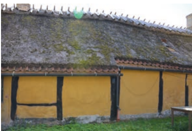
Udsnit af henholdsvis syd- og nordfacade.
