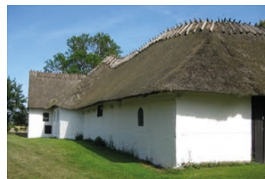
Et stråtag er meget fleksibelt og kan tilpasses fremspring i murværket.
