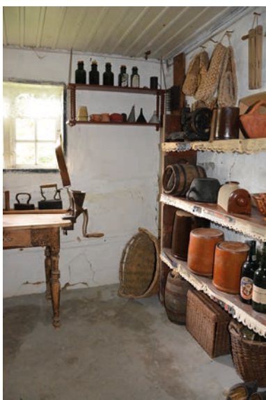
Ressourcerne blev økonomiseret gennem rummernes forskellige detaljeringsgrader. Det nordvestlige spisekammer er ganske simpelt med kalkede vægge og betongulv, som har afløst et lerstampet gulv. Loftet er nyere.
