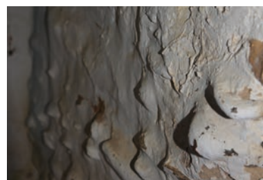
Bryggersets nordvæg, hvor tavlene er opmuret i strandsten.
