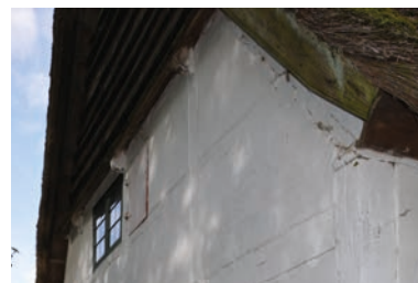
Den traditionelle, mønske helgavl, hvor spidsen er lukket med en vandret bræddebeklædning. Spidsen er udkraget for at beskytte tavlene nedenunder mod regnvandets udvaskning.
