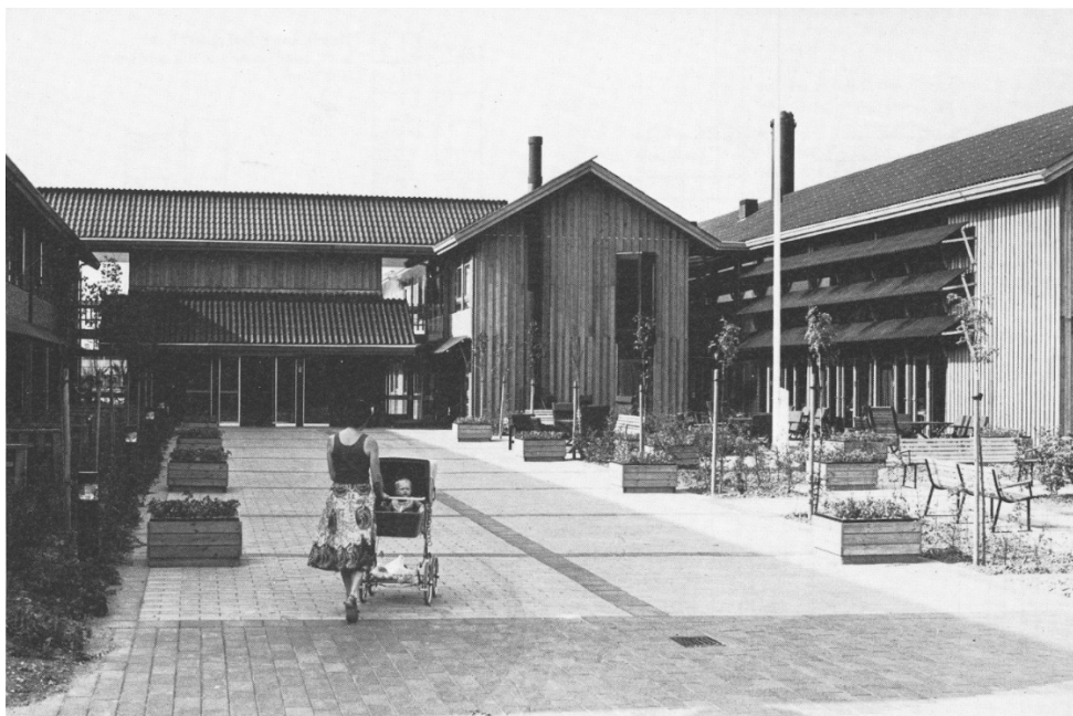
Fig. 1.4.I. Møllegården Omsorgscenter, 1978, indgang til plejehjem og dagcenter. Kilde: Fotografi af Ase Rosing i Erik Ejlers & Henning Graversen, "Omsorgscentret Møllegården, Gladsaxe," Arkitektur DK 22 , no. 6 (1978): 231.
