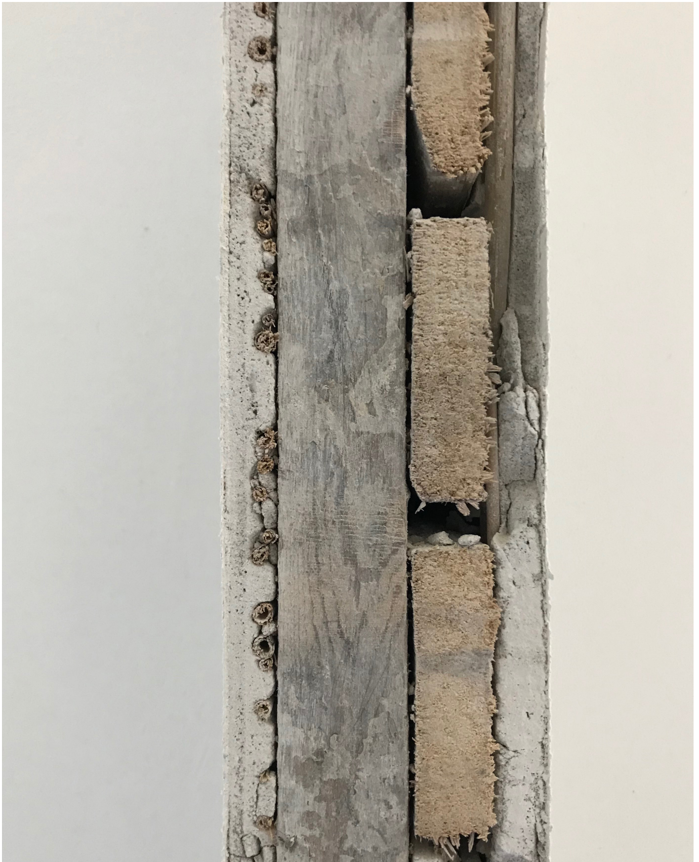
Bræddeskillevæg i etagebolig fra 1926.
