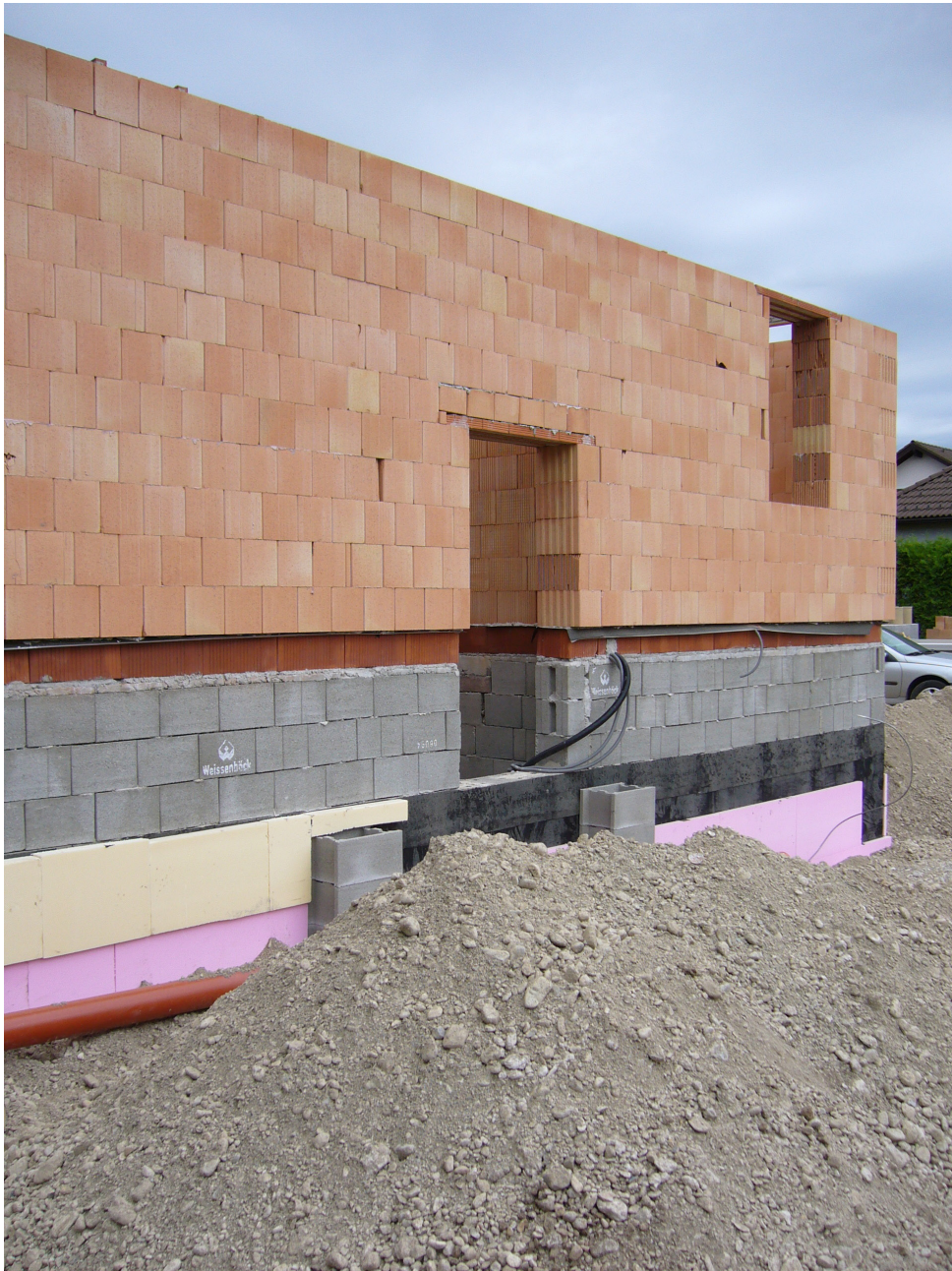
Byggeplads med enfamiliehus i Østrig, hvor teglblokke bruges til opbygning af ydervægge Foto Nini Leimand
