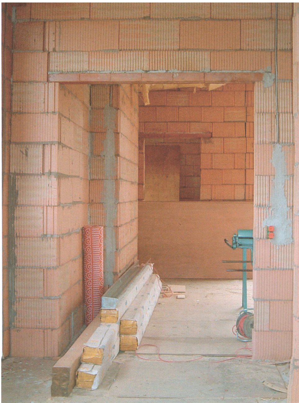
Indvendige skillevægge udføres i smallere blokke, hhv. 110 mm for ikke bærende vægge under 3 m, og 175 mm for højere og bærende skillevægge. El- og andre installationer fræses ind i blokkenes overflade, eller føres synligt. Foto Anne Beim
