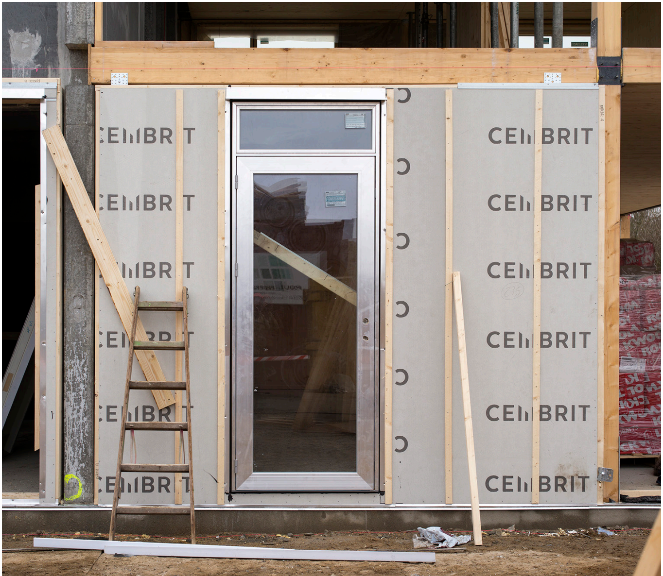
Trækassetter er produceret på en fabrik beskyttet for vejrlig. De lette kassetter med beskyttende vindspærre transporteres til pladsen, løftes på plads og fastgøres til skeletkonstruktion, samt kerner og terrændæk i top, bund og sidder med skruebeslag.
