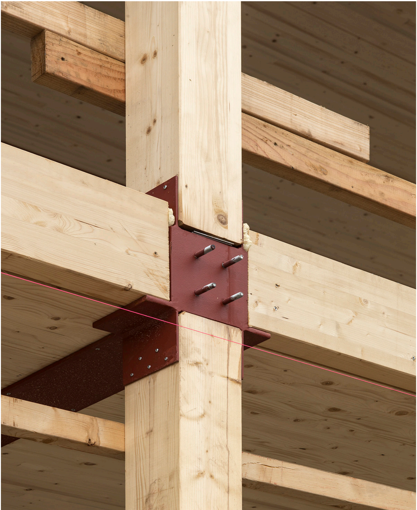
De påsvejste gevindstål er tiltænkt montage af altaner og gangbroer.
