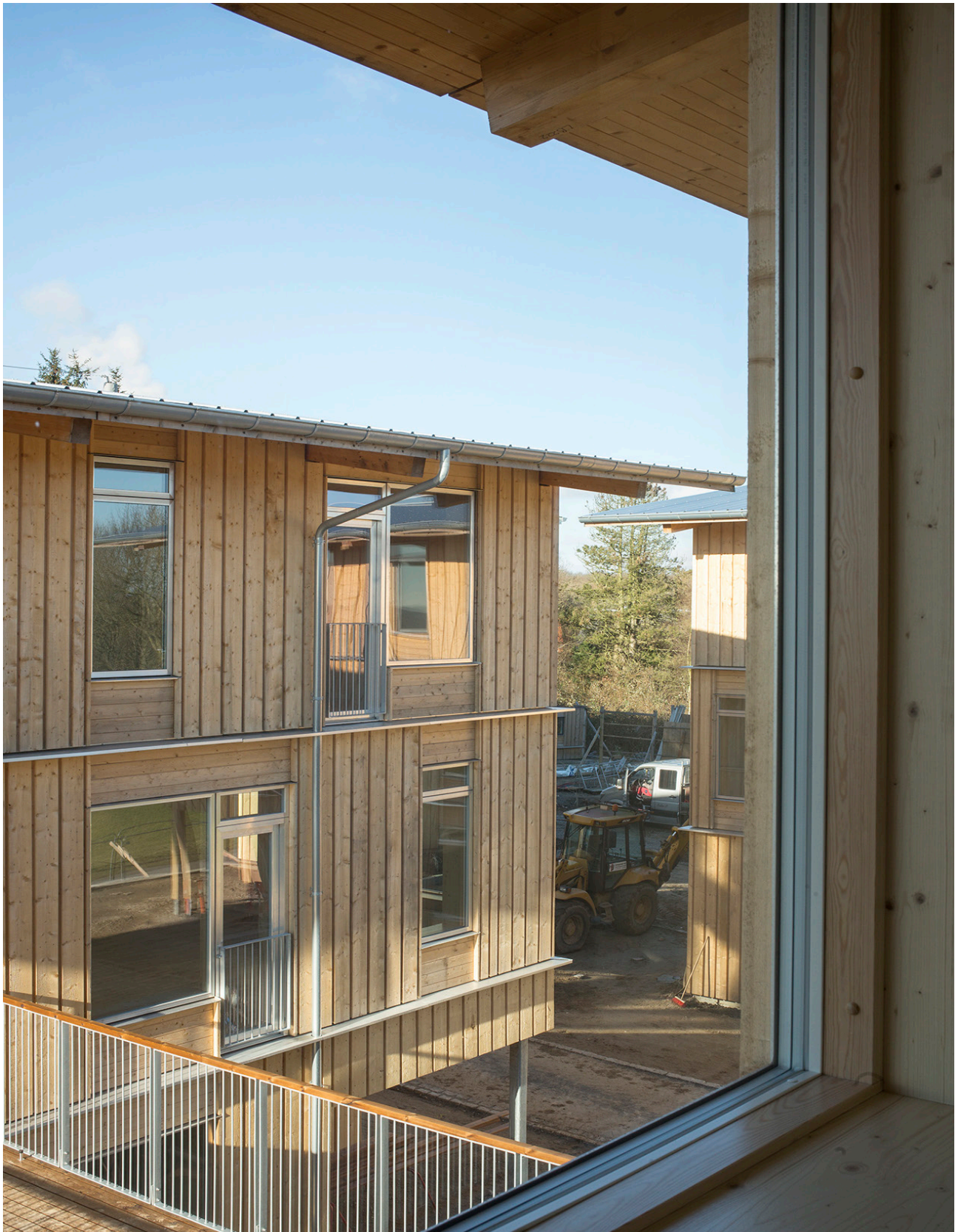
Tagudhænget på 1500 mm er markant og karaktergivende, men tjener også som afgørende konstruktiv træbeskyttelse.
