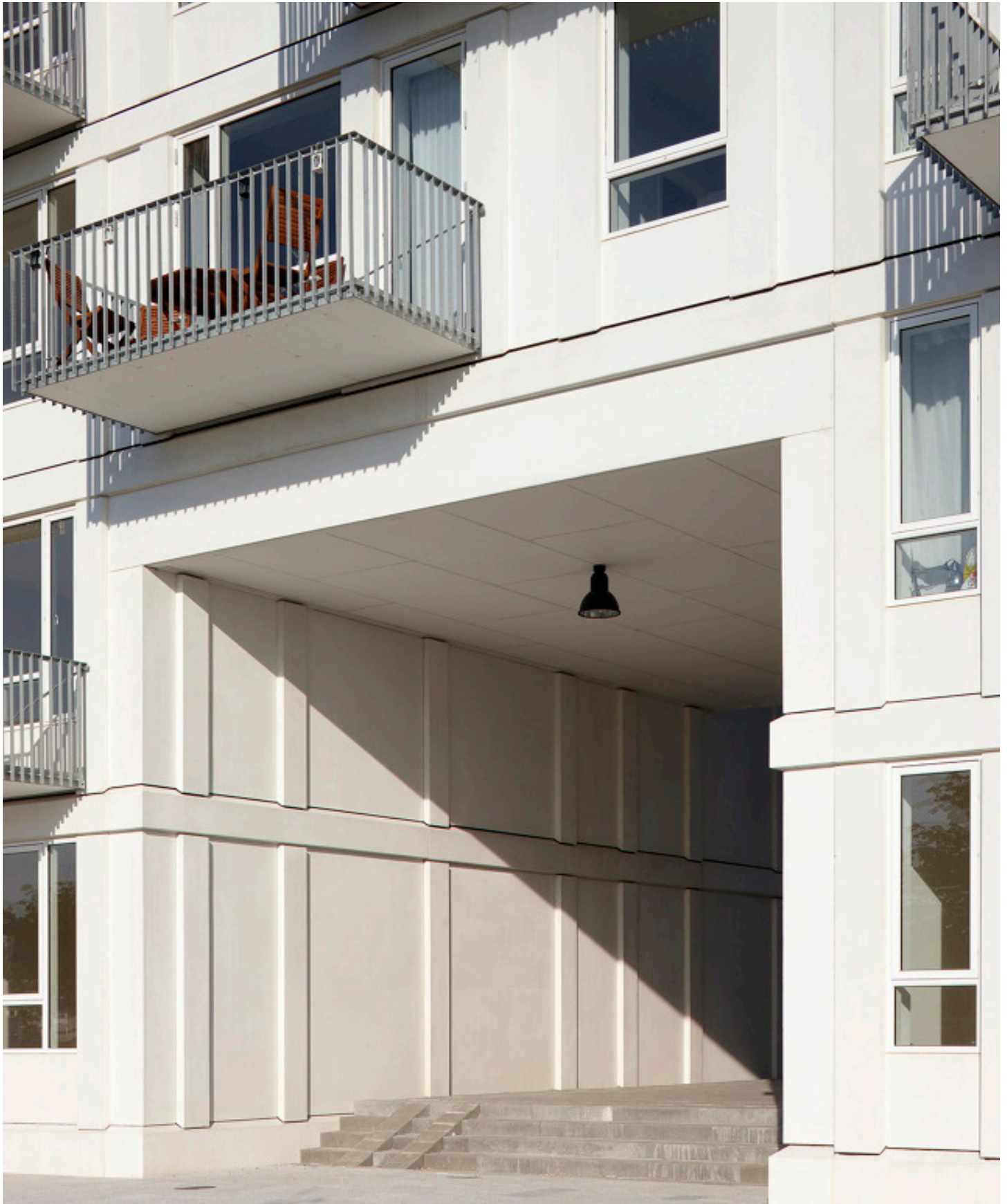
Altanerne er spinkle. Dette kan lade sig gøre fordi det skråstillede trækbånd sammen med bundrammen og det lodrette profil danner en trekant/arm som er boltet fast i den forstærkede pilaster. Facadeelementerne er lysende hvide eftersom der som tilslag er anvendt marmor
