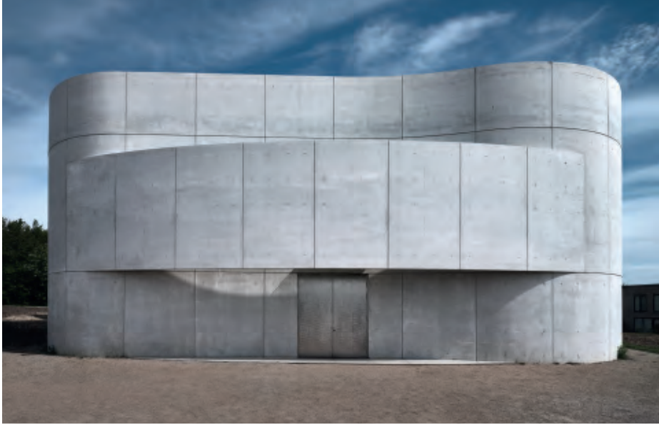
Für die Herstellung der organischen Kurven der Kirche fertigte das Bauunternehmen über 200 Gussformen für insgesamt neun In-situ-Güsse an.
