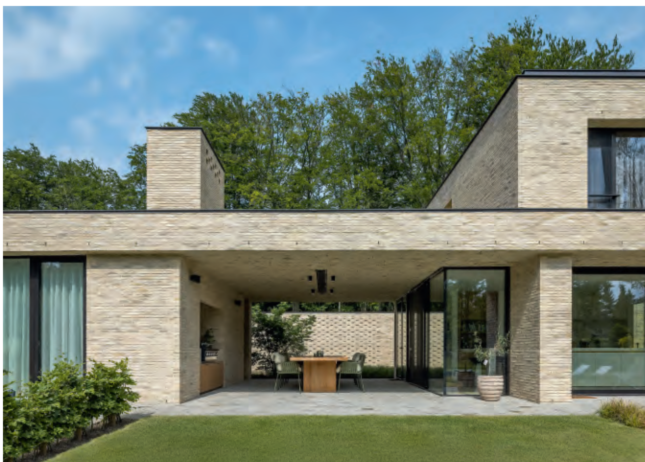
Auf der dem Garten zugewandten Seite überdeckt ein schweres Ziegelband die Terrasse zwischen Wohnhaus und Anbau.
