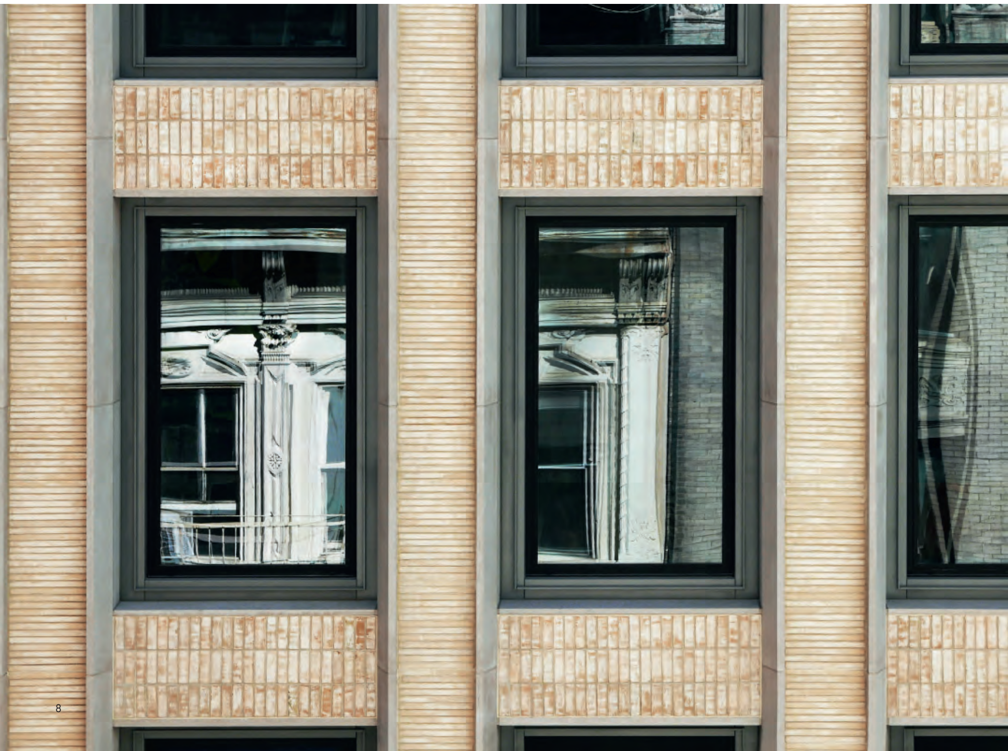
Profilierte Kalksteinrahmen verbinden die Fenster. Der Abstand zwischen den Rahmen entspricht genau der Länge eines Kolumba-Steins. Die Flächen zwischen den Fenstern wurden mit senkrechten D71-Steinen im Hamburger Format verkleidet. Foto: Adrian Gout
