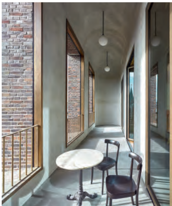
Loggiaen på 4. sal har tøndehvælv, apsis-formede endevægge og konkavt afskårne værn: alt sammen buede former, der skaber kontrast til bygningens mange rette, stumpe og spidse vinkler.
