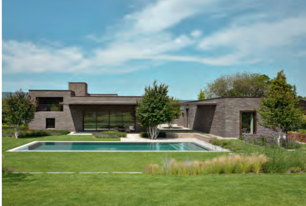
Husets køkken-opholdsrum åbner sig med et kæmpestort glasparti mod haven og en pool. Hele glasfladen kan skubbes til side og skjules i de flankerende mure.
