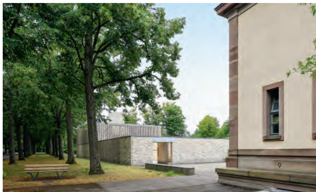
Der hellgelbe Farbton von D71 stimmt mit dem beigefarbenen Putz der älteren Kapelle überein, der graue Farbton von D91 entspricht der Farbe der dekorativen Sandsteindetails.
