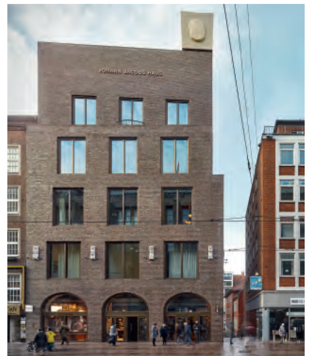
Bygningen bliver trinvist smallere opadtil, mens vinduerne samler sig omkring midten. En subtil reference til Bremens historiske trappegavl.
