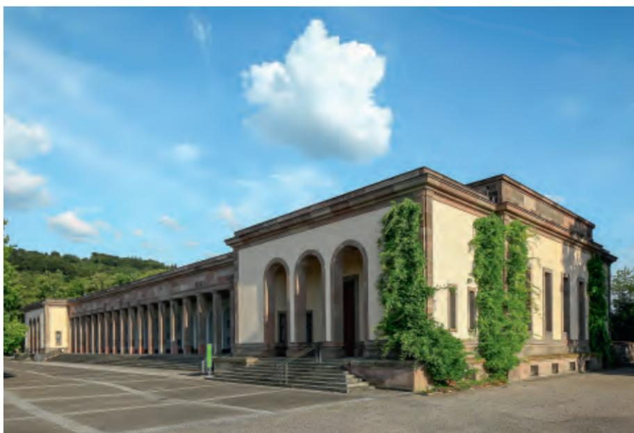
Der hellgelbe Farbton von D71 stimmt mit dem beigefarbenen Putz der älteren Kapelle überein, der graue Farbton von D91 entspricht der Farbe der dekorativen Sandsteindetails.
