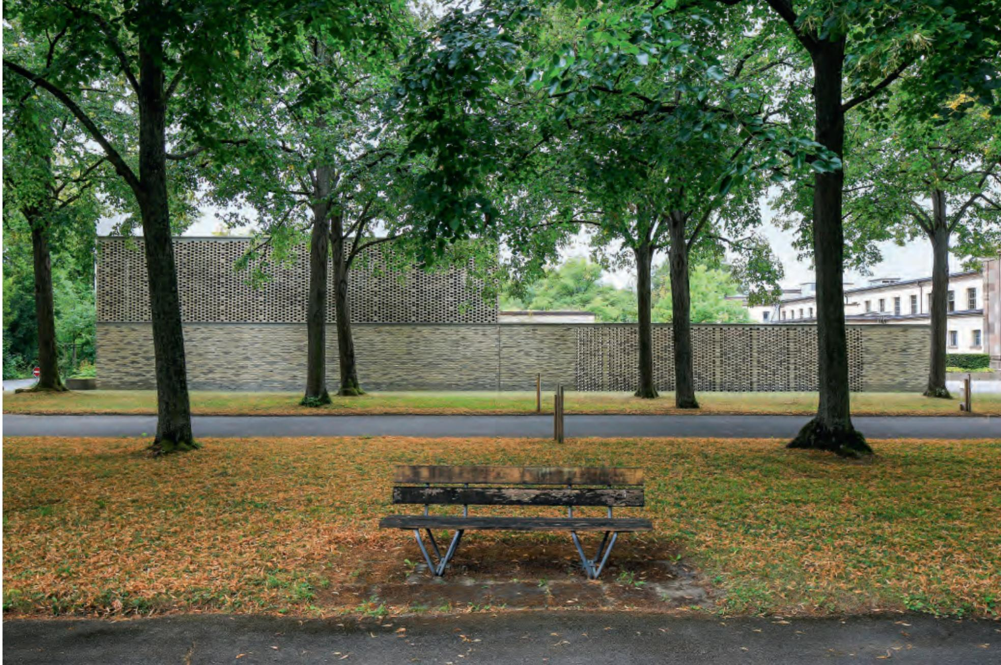
Das Krematorium auf dem Friedhof am Hörnli liegt an einer existierenden Lindenallee. Der Architekt Bernhard Maurer entschied sich für eine Mischung aus D71 und D91, um einen camouflagearartigen Effekt zu erzielen, der das Gebäude mit seiner Umgebung verschmelzen lässt.
