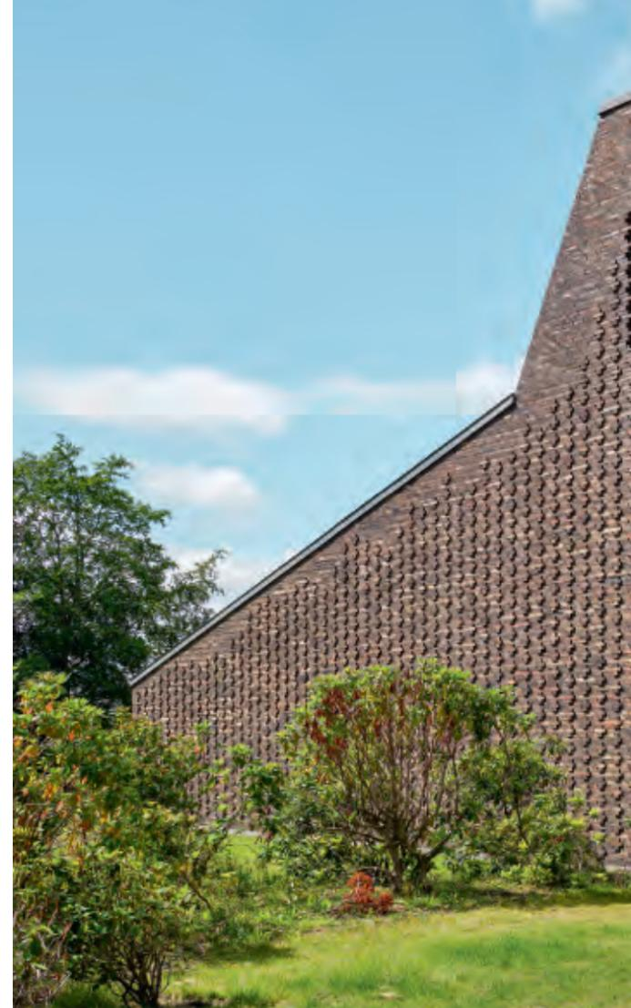
Das gemusterte Ziegelmauerwerk der Fassaden erzeugt einen auffälligen Reliefeffekt, der für Variation und Lebendigkeit auf den großen Flächen sorgt. Das Muster wird teils durch hervorgezogene Steine, teils durch Öffnungen erzeugt.
