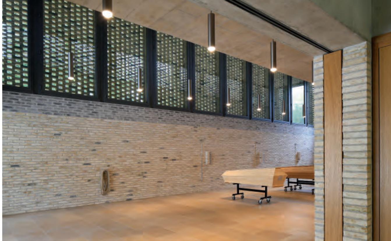
Im doppelhohen Ofenraum besteht der untere Teil der Wand aus hellgelben D71, während der obere Teil als Band aus grauen D91 ausgeführt ist. Licht dringt durch Fenster ein, die sich hinter dem Mauerwerk der Fassade befinden.
