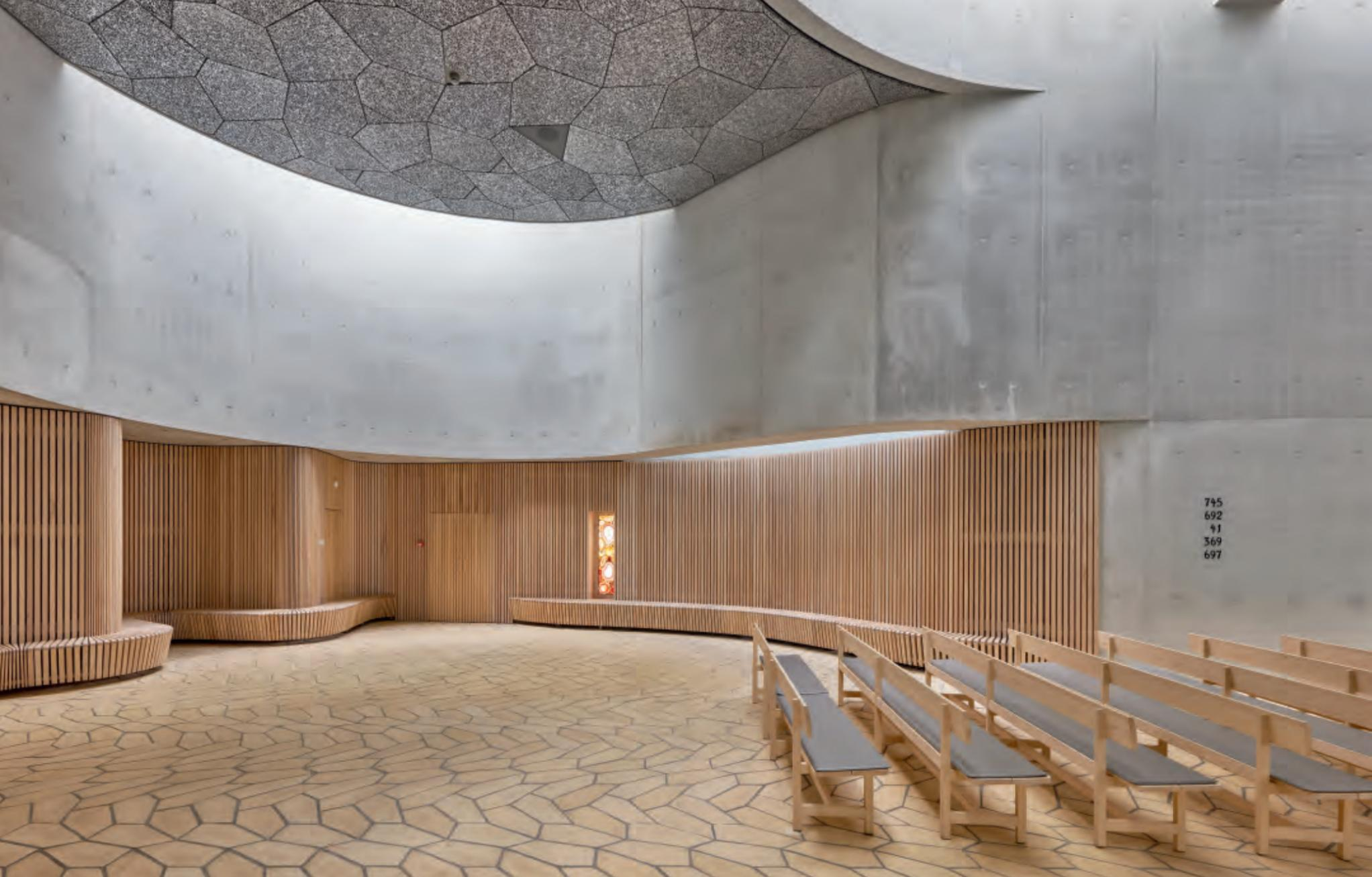
Die Geometrie des Bodens setzt sich in der Decke fort, die aus acht verschiedenen Fünfecken besteht. Das Material ist geschäumtes, mit einem Wasserstrahl geschnittenes Aluminium aus recycelten Aluminiumdosen, das sowohl Licht reflektiert als auch schalldämpfend wirkt.
