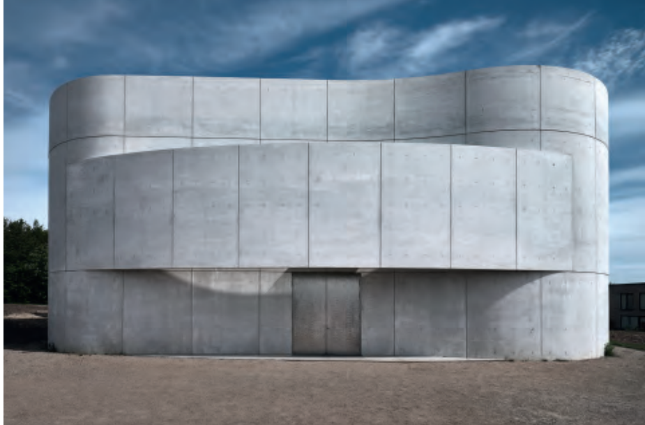
Til fremstilling af kirkens organiske kurver fremstillede entreprenøren over 200 forme til i alt ni in-situ støbninger.
