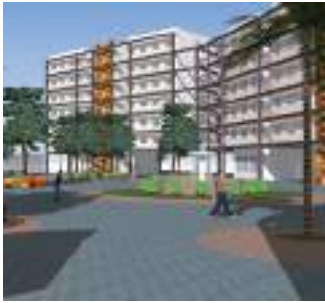
EDIFÍCIO ROCIO PEQUENO ROCIO PEQUENO BUILDING
