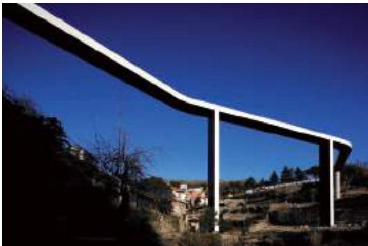
Ponte de Pedestres sobre a Ribeira da Carpinteira - JLCG Arquitectos, Covilhã 2010 Pedestrian Bridge over Ribeira da Carpinteira - JLCG Architects, Covilhã 2010
