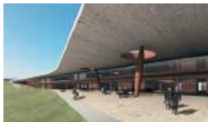
Studio Archea Comune di San Casciano Val di Pesa, Marchesi Antinori – Progetto della Nuova Cantina a Bargino
