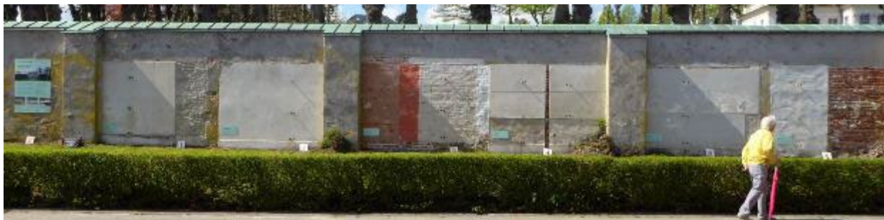
'Marienlyst slotsmur' i Helsingør, der netop har omhandlet egenskaberne for forskellige typer puds af luftkalk, hydraulisk kalk og portland cement
