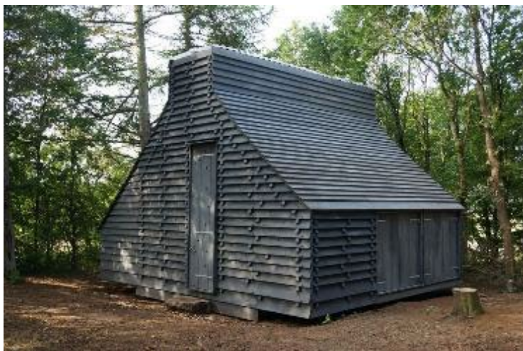
Gram Å-hytten i Sønderjylland – bygget som led i del-projektet 'Nye TRÆHUSE helt af træ' #2 - af 20 arkitektstuderende og 4 lærere i sommeren 2020 på en grund, tæt ved Gram Å i Sønderjylland.
