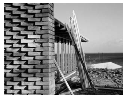
Figura 13. Construcción del muro de ladrillo girado junto a la cafetería del Museo Louisiana de 1958 antes de ser revocado. Fotografía del arquitecto danés Ebbe Clemmensen. Imágen propiedad de la Danish National Art Library, Collection of Architectural Drawings, Collection of Architectural Pictures.
