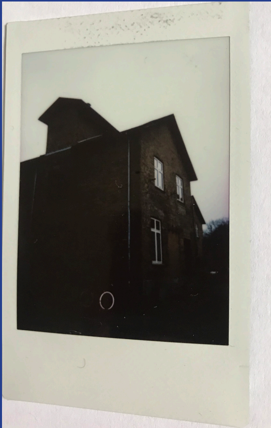
Foto af "bagside" af bygning langs muren mod vest.
