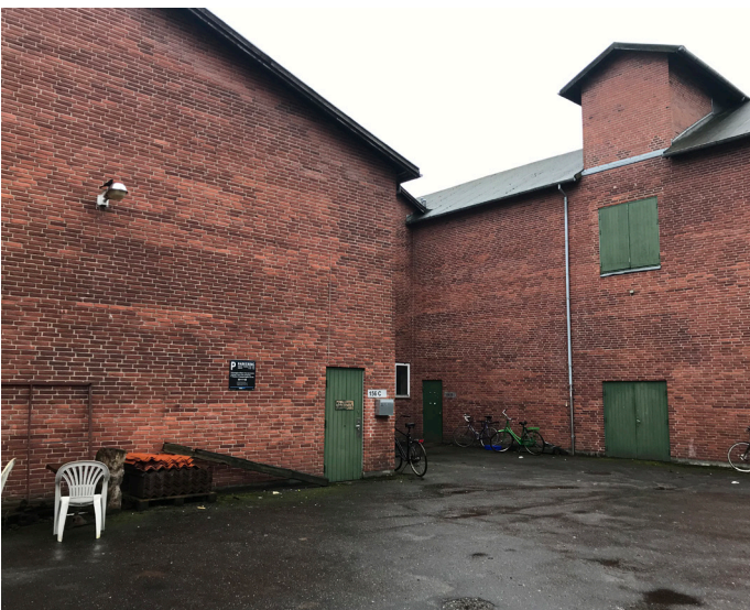
21. Til venstre, pladsdannelse mellem bygninger
