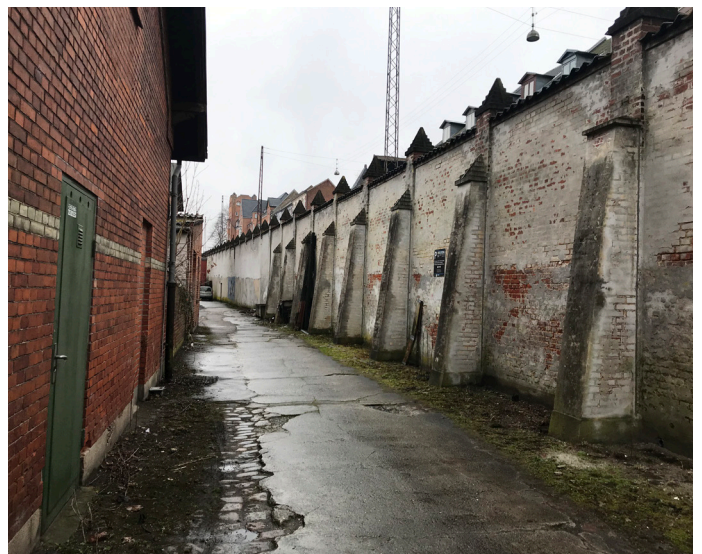
18. Blik ned langs muren, mod syd.
