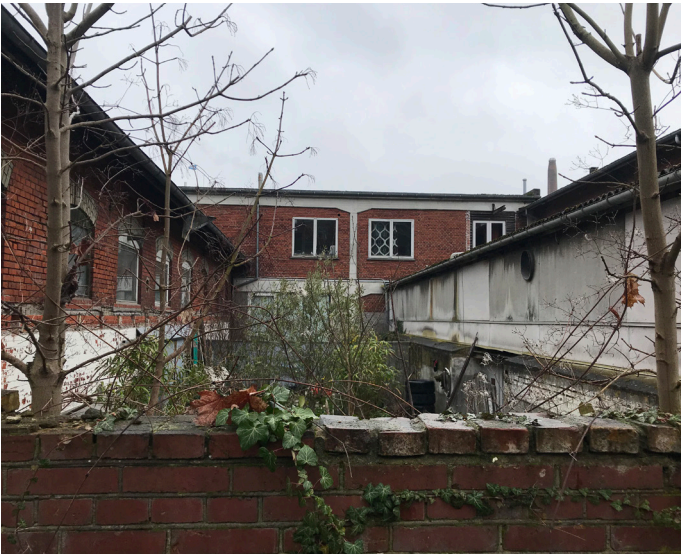
19. Til venstre, afgrænset privat have/terrasse
