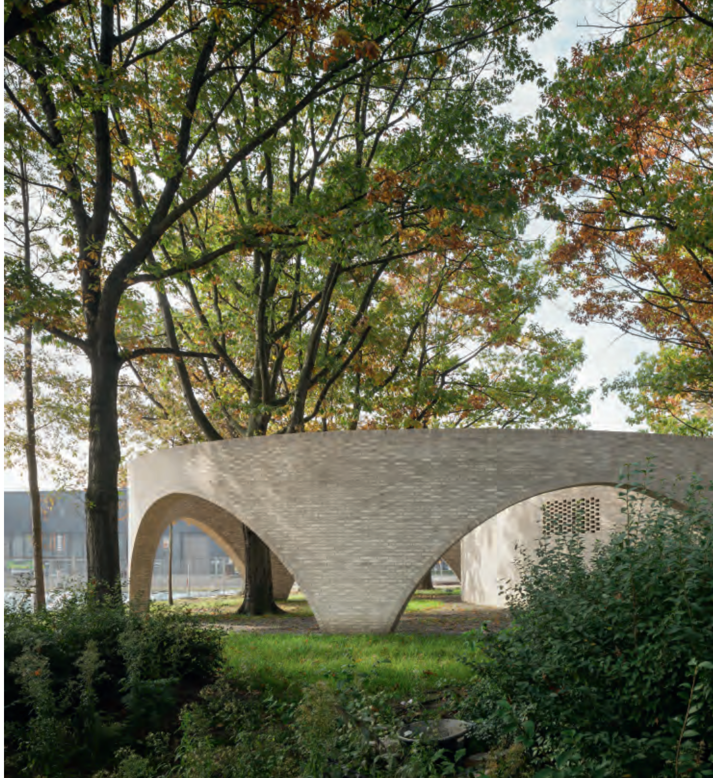
Die drei gemauerten Trafostationen des Straßenbahnprojekts Brabo 2 in Antwerpen bestehen aus außergewöhnlich hochwertigem Mauerwerk, wie man es nur selten bei modernen Bauprojekten sieht.
