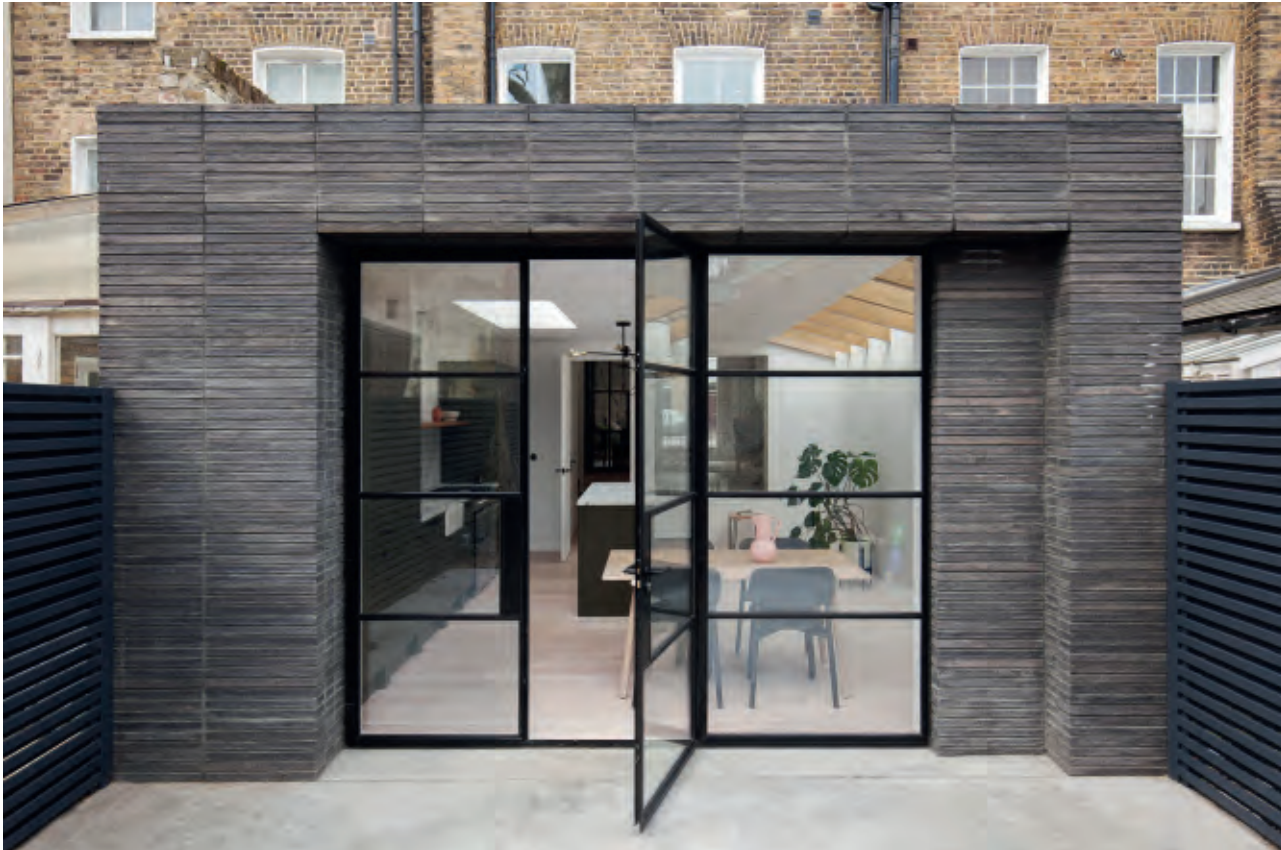
HÛT Architecture entwarf den Erweiterungsbau mit einer präzisen und dichten, zum Garten ausgerichteten Fassade. Der dunkle, handgefertigte Kolumba in Kacheloptik passt wunderbar zur Glasür aus schmalen, schwarz lackierten Profilen.
