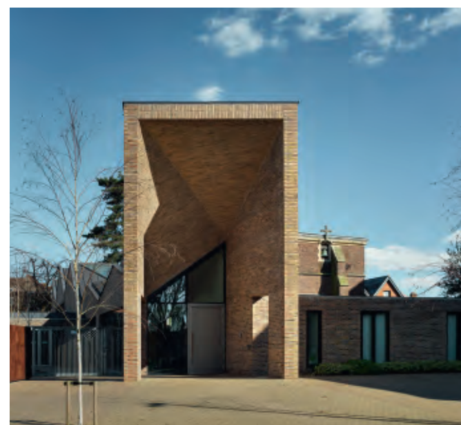
Der Eingang bildet ein kirchturmähnliches Motiv im Straßenbild.
