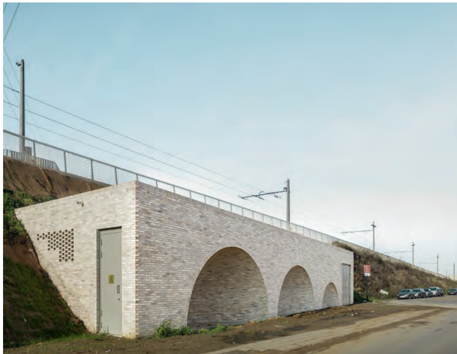
Die Station Tjalkstraat mit ihren drei unterschiedlich großen Doppelbogengewölben schneidet sich in den Bahndamm ein, auf dem die Züge fahren.
