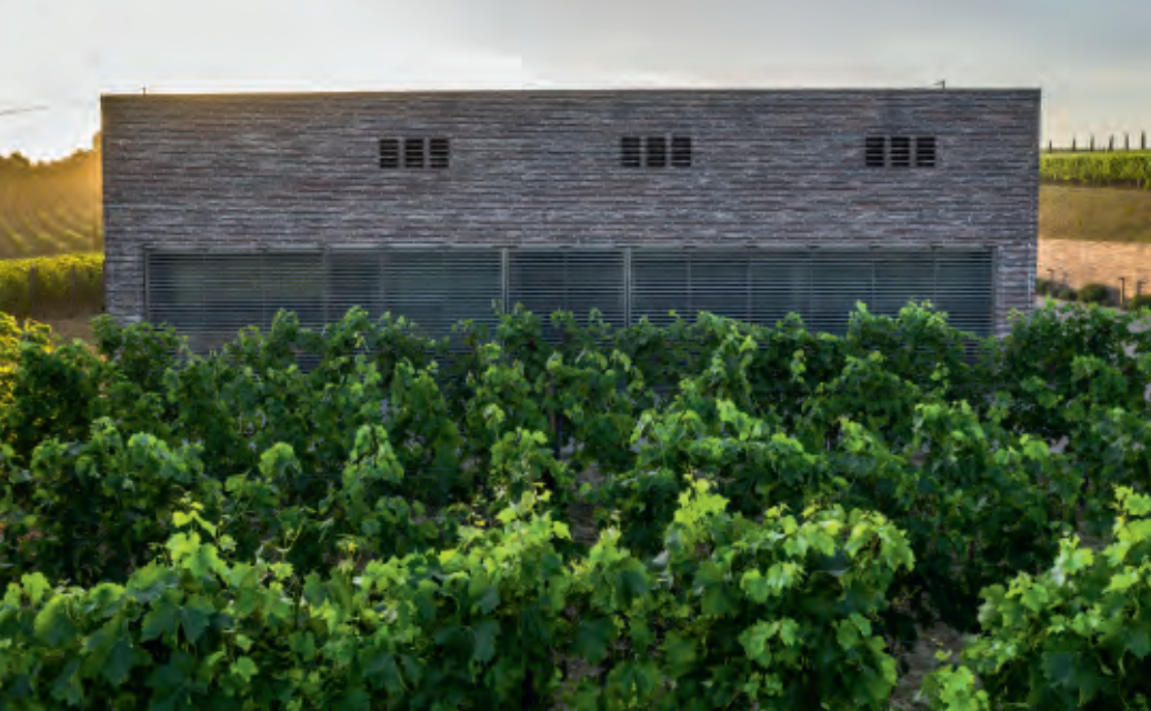
Solafskærmningen, udført som trælameller, i hele den østvendte facade kan efter behov skærme næsten fuldstændigt for solen eller give skygge på terrassen.
