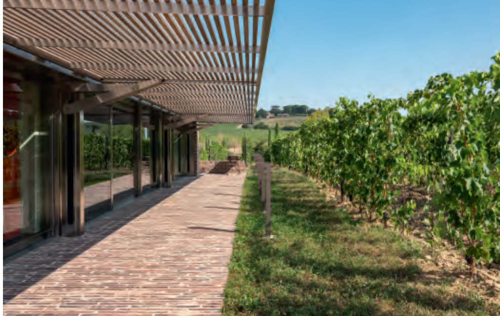
Vinduer fra gulv til loft skaber forbindelse mellem ude og inde i bygningens mere offentlige zone. Belægningen langs bygningen er også udført i Kolumba.
