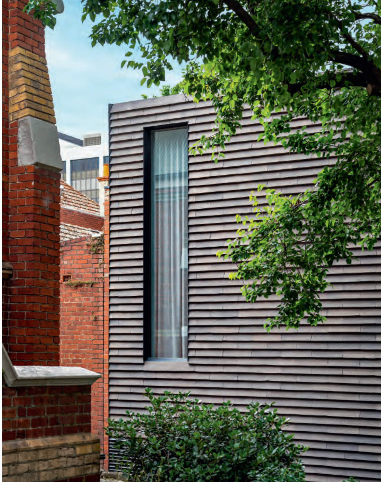
Cover-stenens håndtilvirkede udtryk skaber subtile variationer hen over facaden. I løbet af dagen understreger lagdelingen forandringer i sollyset.
