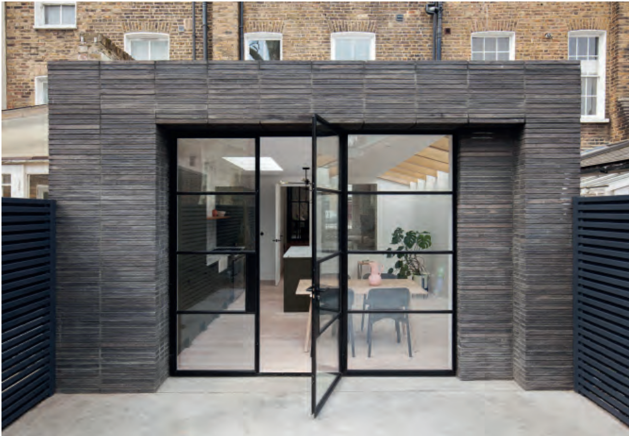
HÛT Architecture udformede tilbygningen med en præcis og stram facade mod haven. Den mørke, håndtilvirkede Kolumba i fliseforbandt er velvalgt sammen med dørpartiet i smalt dimensioneret, sortmalede profiler.
