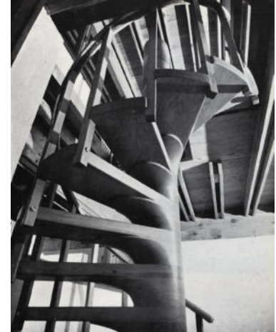
Fig. 14. Escalera Casa Santonja. Fuente: Fernando Higuera, «Casas en el campo», Arquitectura , n.o 97 (1967): 45-50.
