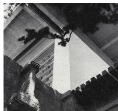
Fig. 3. Casa César Manrique. Fuente: Fernando Higuera, «Casas en el campo», Arquitectura, n.o 97 (1967): 45-50.
