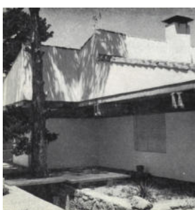
Fig. 9. Casa César Manrique: Fuente: Fernando Higuera, «Casas en el campo», Arquitectura, n.o 97 (1967): 45-50.
