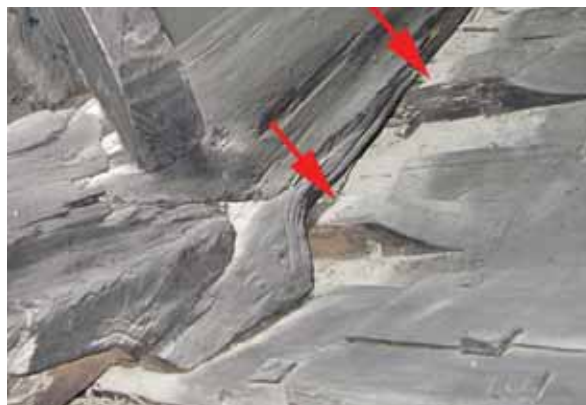
Fig. 6.14. Glendes skitse af en klampe, hvor overkanten er tegnet konkav, selvom den oprindeligt var flad, som vist på foto th. så bundstokken har hvilet udelukkende mod klampen og ikke mod bordgangen (Glende 1904, 13). Foto taget op gennem et hul fra en dendro-prøve. Foto forfatteren.
