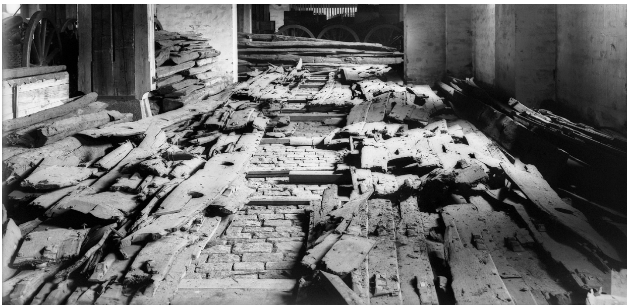
Fig. 3.5. De 2000 dele, som lå på gulvet, var stærkt forvredne og ude af deres oprindelige form. For at samle skibet måtte Johannessen derfor tage nogle afgørende valg for at kunne få delene til at passe til skibopstillingen. Foto Kulturhistorisk Museum i Oslo.
