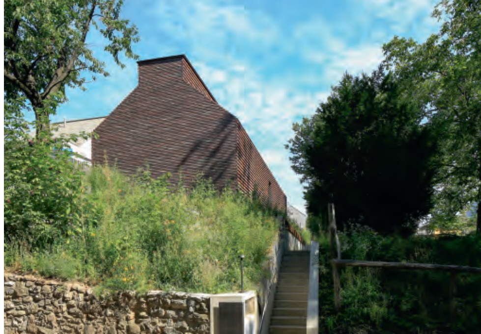
En trappe i in situ-støbt beton leder op til Atelieret fra den lille skovsti. Med den rødbrune teglfacade har arkitekterne tilstræbt en rolig og kontrasterende baggrund til de grønne omgivelser.
