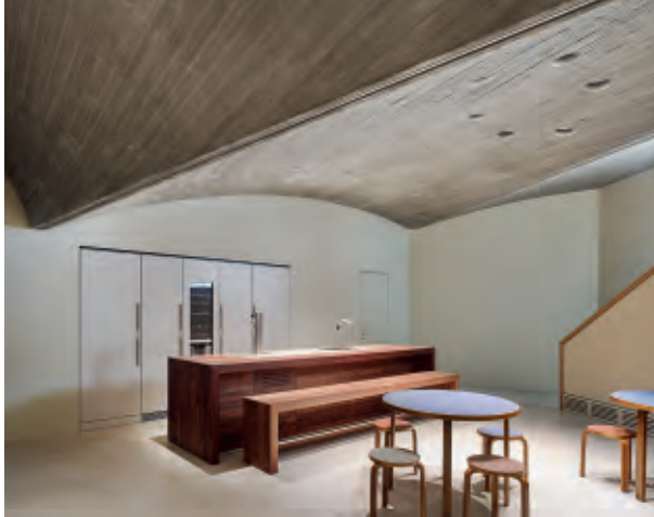
Loftet i kælderen er ikke bærende og in-situ-støbt og kunne derfor udformes som asymmetriske hvælv.
