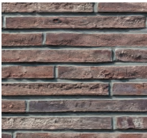
K4 laves af engelsk ler, hvor der tilføjes sand i træformen. Sandet præges ind i leret under brænding, hvorved stenen opnår sit karakteristiske udtryk.
