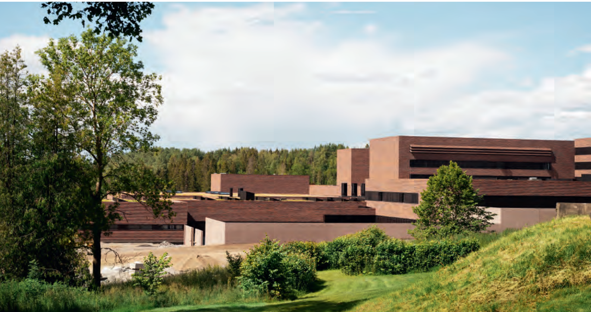
Det nye Campus Ås er skabt ved at bygge otte bygningskroppe sammen. Størstedelen af husets kvadratmeter er placeret under terræn for at minimere bygningsens synlige volumen i landskabet. Foto: Jacob Due
