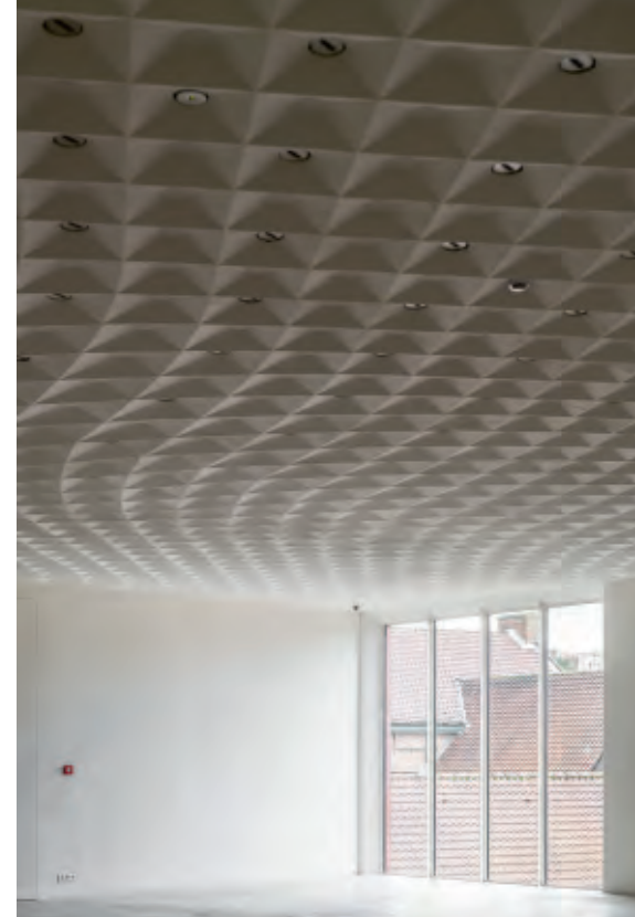
Fra det store udstillingsrum på øverste etage er der kig ud over haven. Kassetlofter kendes tilbage fra oldtidens monumentalarkitektur, men har her fundet en nutidig form. De bølgende linjer støbt i in-situ-beton synes at spejle den besøgendes gang gennem rummet. Foto: Olmo Peeters
