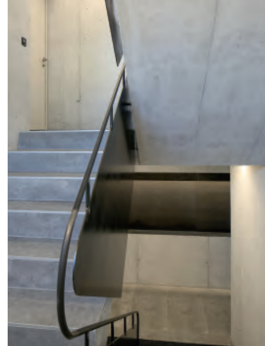
Trappen er udført i beton og med håndliste og delvist værn i jern i en ubehandlet finish, der patinerer, så den sorte grundfarve changerer med grønne og blå toner.
