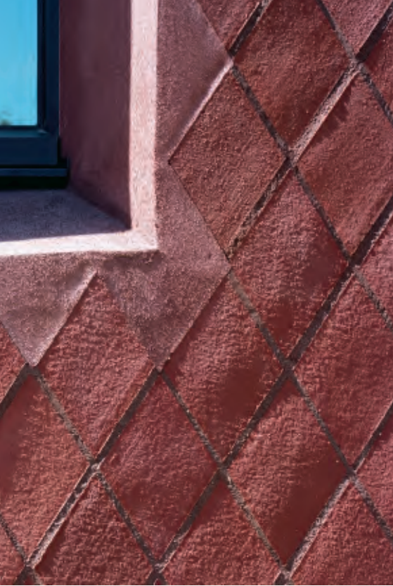
De rombeformede tegl er dimensionerede, så de harmonerer med murstenene i de omkringliggende, historiske bygninger. Stenenes håndlavede struktur reagerer på lyset og gør muren levende. Foto: Gion von Albertini
