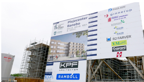
Byggeriet er i gang - her bygges de første plejeboliger.
