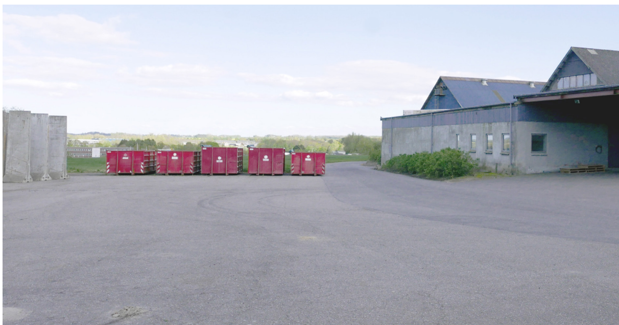
Odder Nord ligger højt, og store overflader samler store mængder vand, der skal håndteres i kloaksystemet. Der er imidlertid god plads til lokal håndtering af regnvand, hvis de grønne mellemrum udnyttes til opsamling og forsinkelse af regnvandet.
