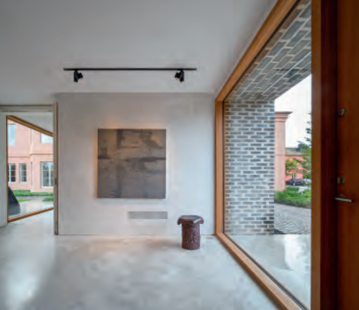
Der Boden aus Ortbeton wurde in den Garten hinein verlängert – ein Substitut für den nicht vorhandenen Sockel.
