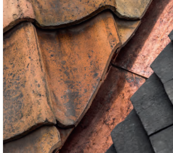
Zusammen mit Petersen Tegl entwickelten die Architekten den dunkelgrauen, handgefertigten Dachziegel mit den Maßen 265 x 182 x 20 mm.
