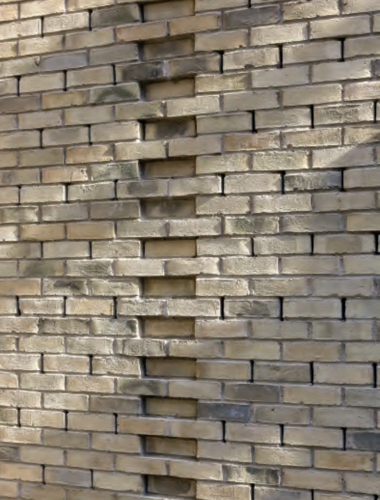
Die Mauer bildet eine Fassade zum überdachten Achterplaats und ist mit ihren offenen Fugen ein Teil der Belüftungsanlage. Sie dient außerdem als Akustikwand. Foto: Paul Kozlowski
