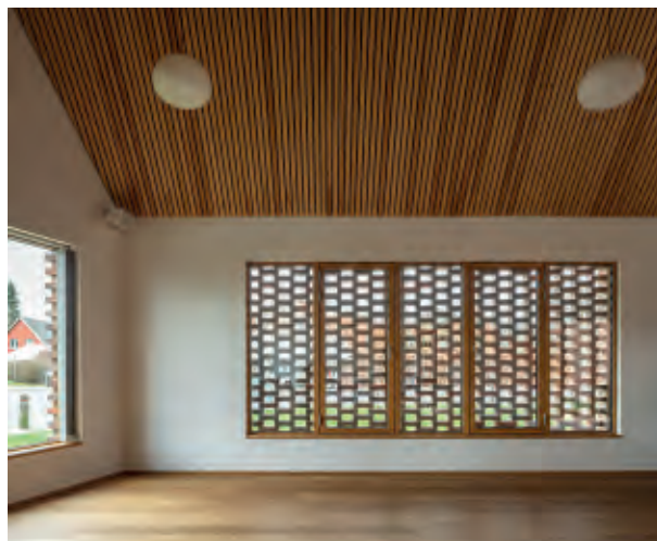
Eine perforierte Mauer vor den Fenstern des Gemeinschaftsraumes verhindert eine Beeinträchtigung durch die Scheinwerfer vorüberfahrender Autos.
