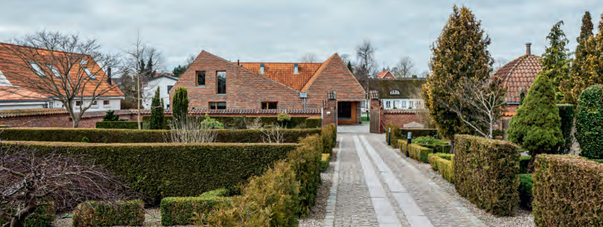
Das Gemeindehaus Vindinge fügt sich durch Größe und Material nahtlos in die benachbarte Häusergruppe des Dorfes ein. Den Neubau und die Kirche verbindet ein mit Kopfsteinpflastersteinen und größeren Granitquadern gepflasterter Weg.
