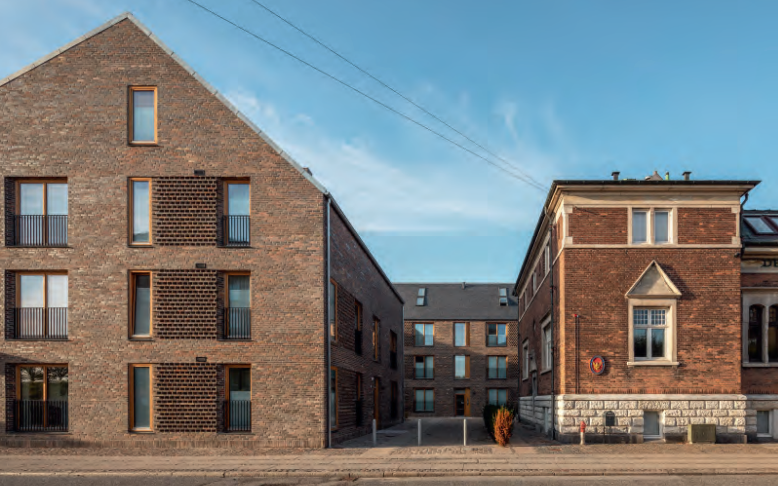
Die historischen Gebäude in diesem Stadtteil wurden mit gemauerten Dekorationen verziert. PLH Architekten hat diese modern und doch klassisch interpretiert, unter anderem mit schräg vermauerten Ziegeln zwischen den Fensteröffnungen.
