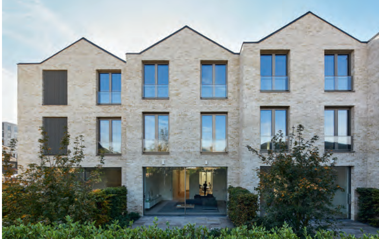
Fünf der sechs Wohnungen wurden als giebelständige, dreigeschossige Reihenhäuser gebaut, die parallel zueinander etwas verschoben sind. Für die Fassaden wurden Ziegel in einem sehr hellen Gelb vermauert, mit eingezogenen Fenster- und Türöffnungen. Foto: Paul Riddle
