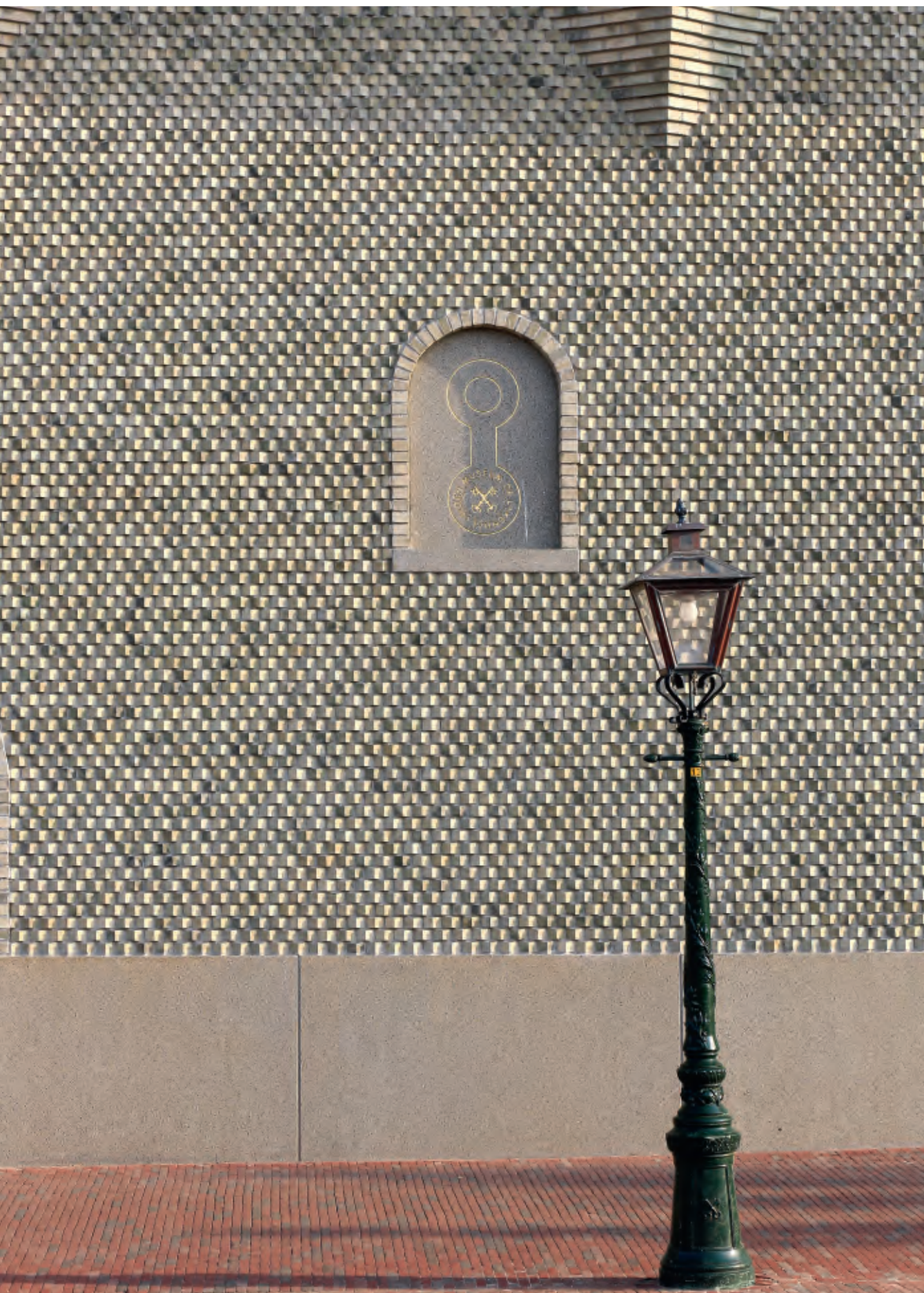
Das Fassadenrelief im Sägezahnverband fängt die niedrige Abendsonne ein. Das Van Steijn-Gebäude ist modern und steht zugleich im Dialog mit der ereignisreichen Geschichte der Stadt. Foto: Paul Kozlowski
