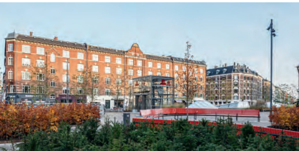
Die Architekten und der Bauherr verwendeten viel Zeit auf die Untersuchung der städtischen Räume in der Umgebung geplanter Stationen, um eine Verankerung der unterirdischen Gestaltung zu gewährleisten. Im Fall der Station Enghave Plads sind es die roten Ziegel.
