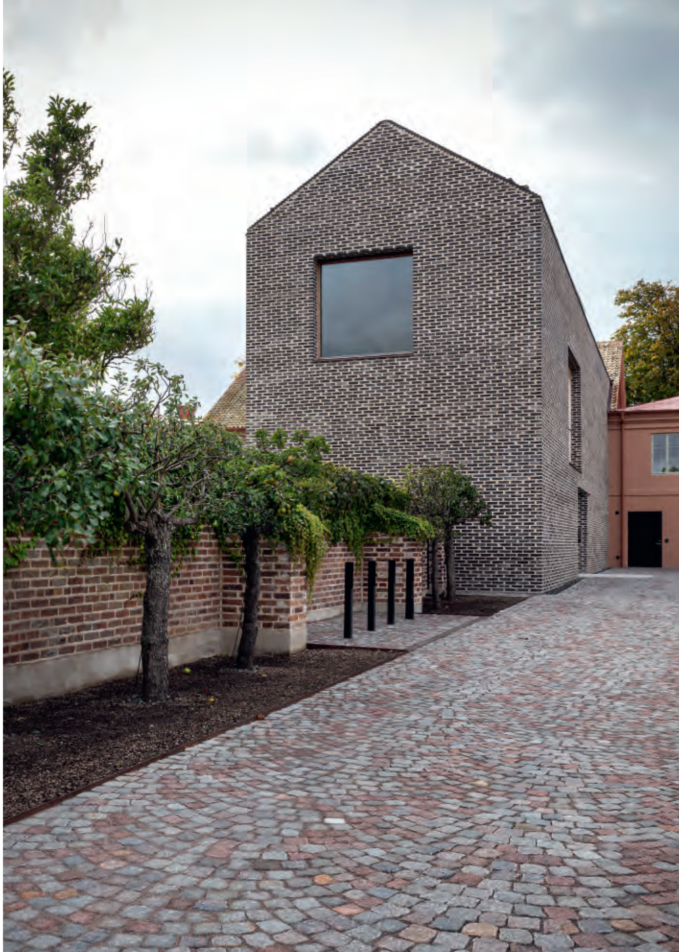
Die klare Form des Anbaus wird vorbildlich durch die Details unterstützt. Dort, wo das Dach auf die Fassade trifft, wurde ein präziser Dachfuß ohne Vorsprünge und Rinnen vorgesehen.
