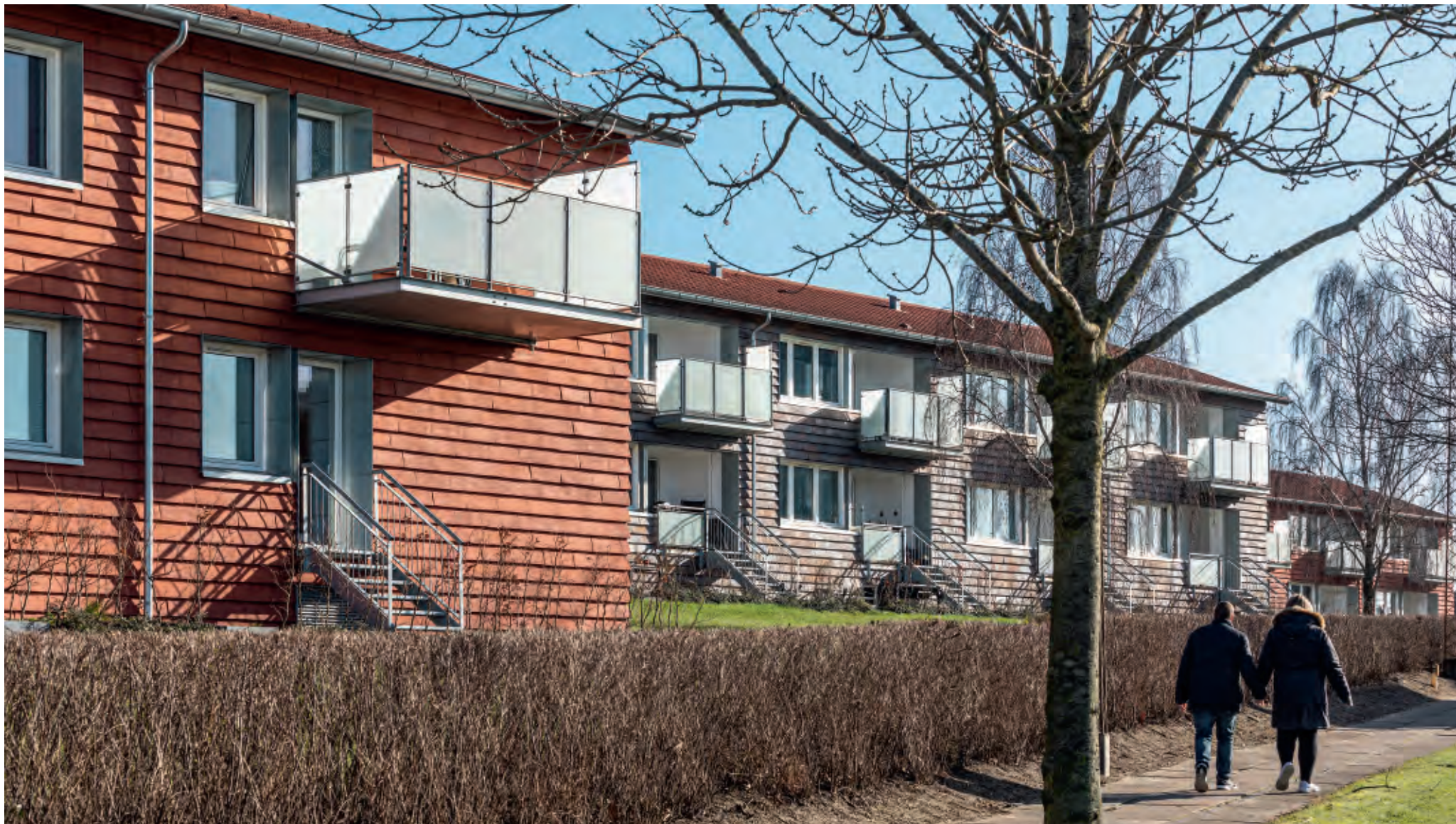
Alle Wohnungen im ersten Obergeschoss haben jetzt Balkons, während alle Wohnungen im Erdgeschoss direkten Zugang zu ihrer Terrasse und der gemeinsamen Grünfläche haben. Die renovierten Fassaden und die besseren Möglichkeiten, sich im Freien aufzuhalten, haben die soziale Gemeinschaft in der Wohnanlage Ringbakken gestärkt.
