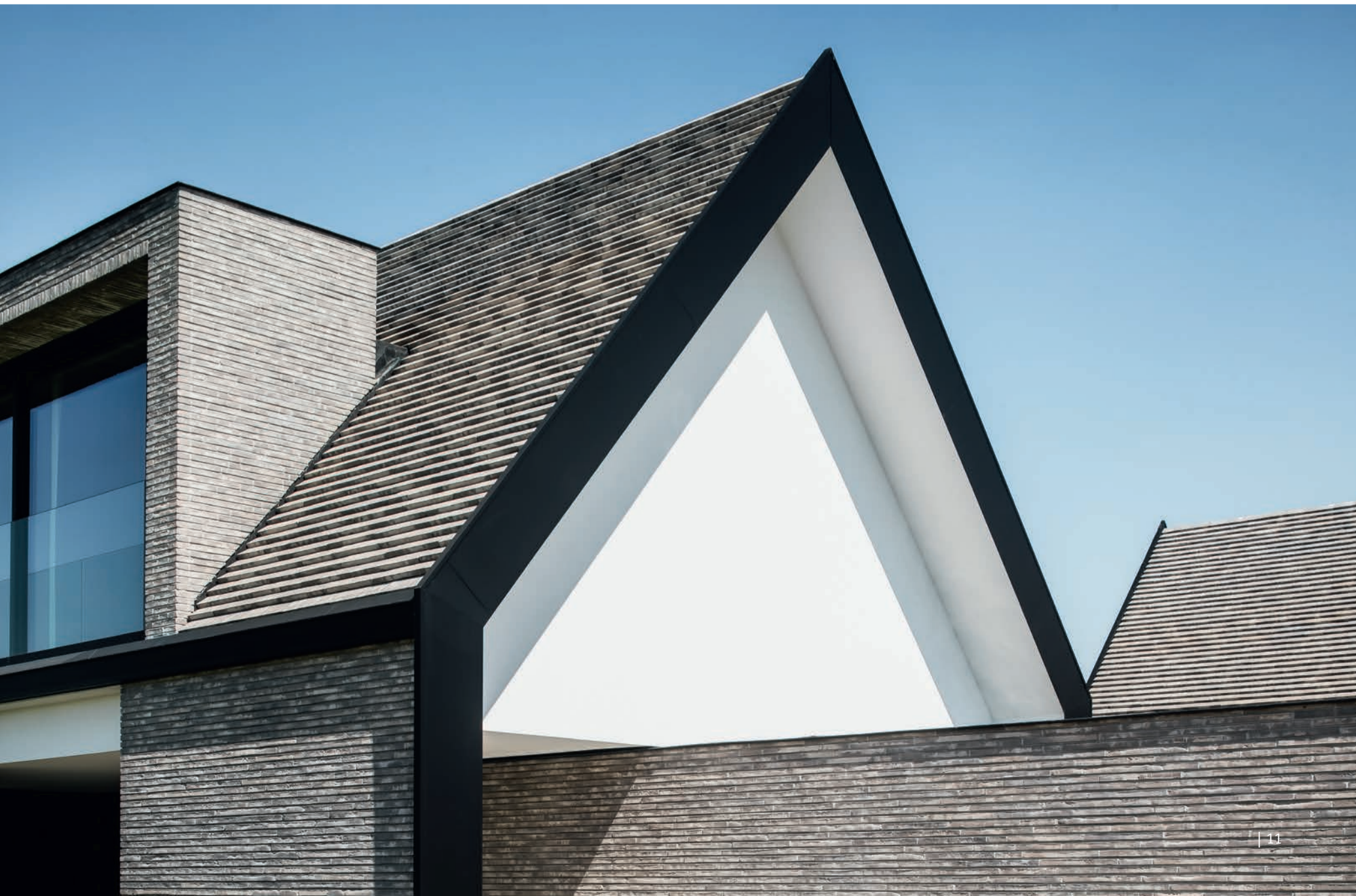
Glatte Flächen in Schwarz-Weiß bilden einen grafischen Kontrast zum Schattenspiel der Ziegel in Grautönen. Die Kolumba der Fassade und die Cover des Daches umhüllen das Haus und lassen es als eine Einheit erscheinen.
