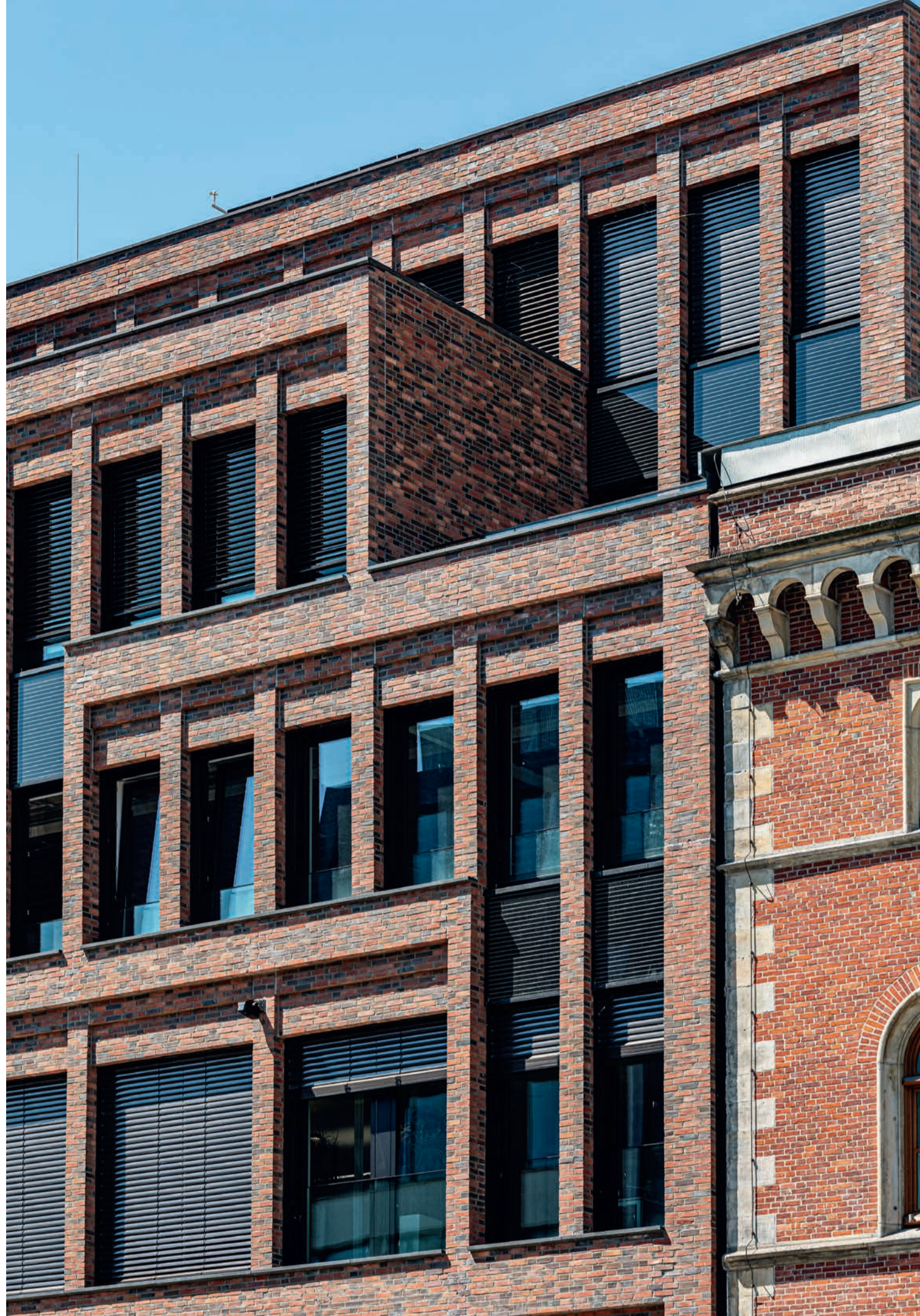
> Die Farbtöne des Kohlebrandziegels D34 zeigen ein breites Spektrum roter, oranger und braun-grülicher Nuancen. Das gleiche Spektrum findet sich im Mauerwerk der Nachbargebäude von Große Bleichen 19.
