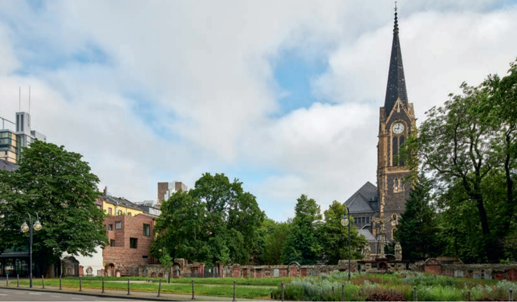
Der Anbau bildet eine neue Fassade zum grünen Peterskirchhof, einem der ältesten Friedhöfe in Frankfurt am Main.
