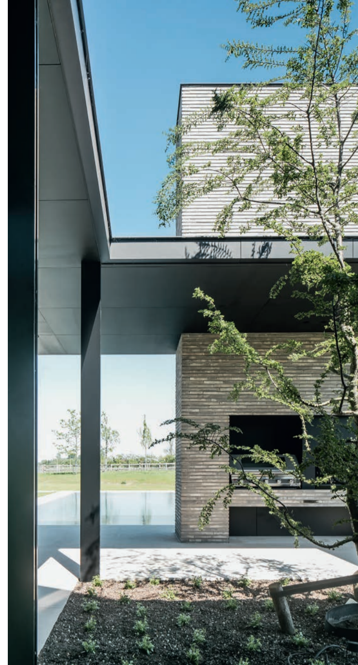
Der große Kaminofen im Freien wurde ebenfalls aus Kolumba gemauert.
