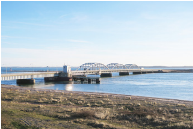
Den kombinerede vej- og jernbanebro fra 1938 med broklap vest for buerne
