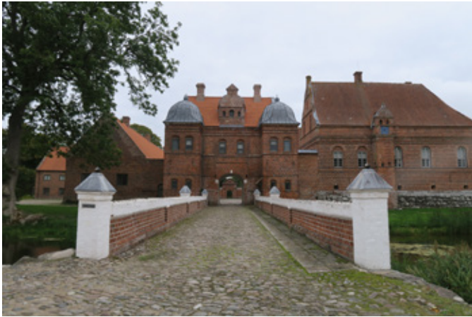
Den stensatte bro og portbygningen, som leder til herregårdens hovedbygning. De to huller over portåbningen indikerer, at der oprindeligt har været vindebro.
