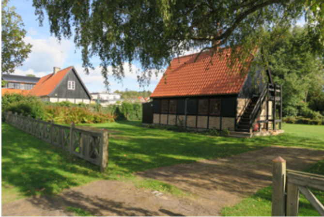
En typisk repræsentant for de tidligste huse i feriebyen opført i bindingsværk, med tavler i blank mur, teglhængt tag og udvendig trappe.
