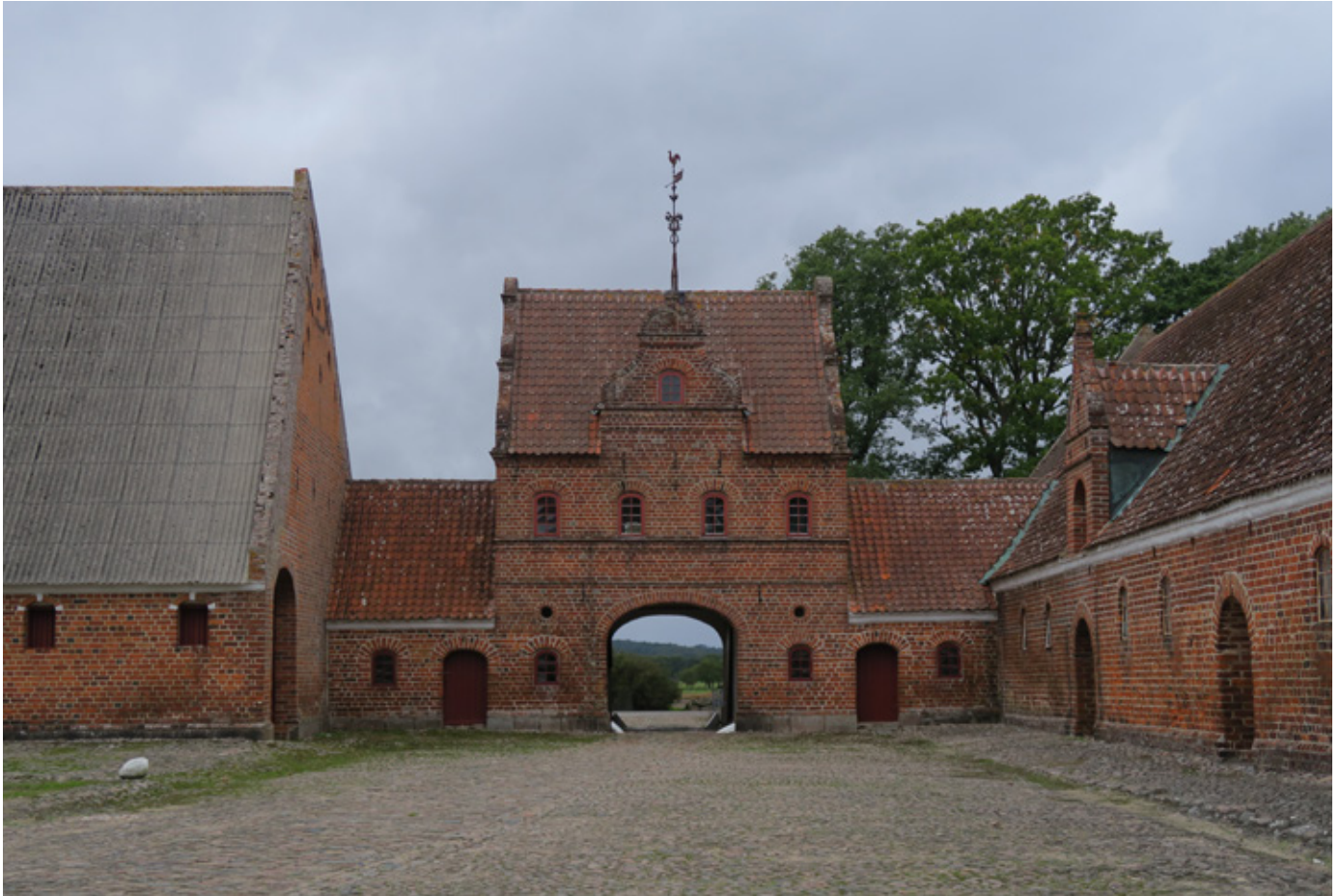
Herregårdens renaissancepræg kommer tydeligt til udtryk i portbygningernes rundbuede vinduer og svungne gavle, mens de store eternittagflader svækker helhedsindtrykket.
