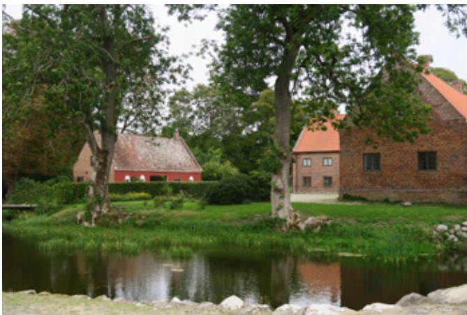
Nord for hovedbygningen ligger endnu en beboelselænge med en sidebygning. Nordlængens sidebygning og det lille hus i et stokværk er ikke omfattet af fredningen.
