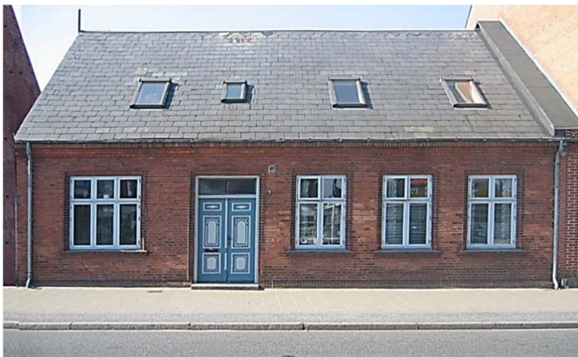
Varde, Storegade 7. Opført 1896. Historicistisk gadehus opført i hårdbrændte ensartede røde tegl med profilerede formsten omkring døre og vinduer. Det naturskiferbelagte tag er typisk for de historicistiske gadehuse.
