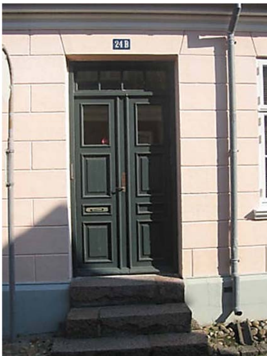
Varde, Nikolaikirkestræde 24B. Opført 1910. Tofløjet fyldingsdør med dobbelt anslagsliste.
