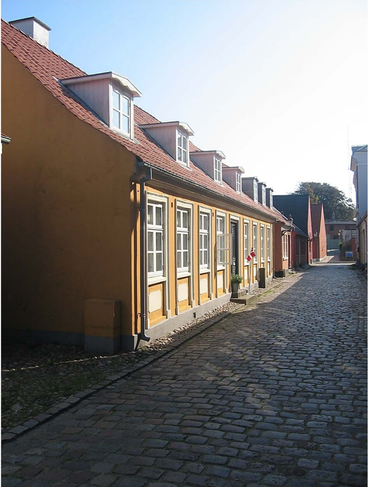
Typisk senklassiske (1835 – 1860) gadehuse fra Varde. Kendbare på de trukne vinduesindfatninger og de markante 'spejl' under alle vinduerne. Plus den kraftige, trukne gesimser.
