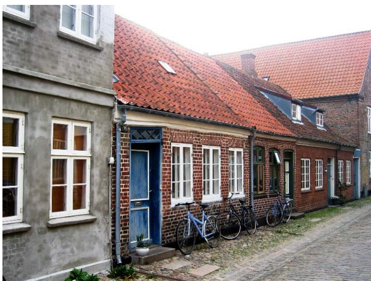
Ribe, Gråbrødregade 11. Facaden grundmuret fra 1837. Enkelt gadehus i den sydvestjyske klassicisme med mørkbrændte tegl og hvide fuger.
