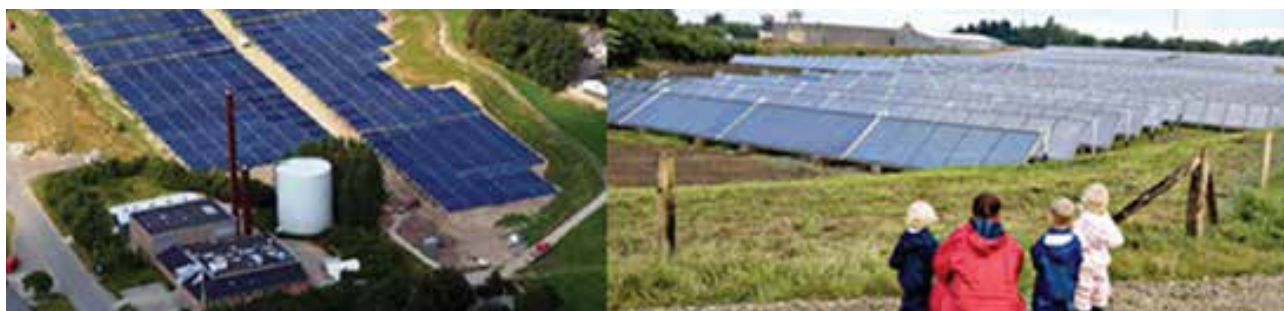
Hos Brædstrup Fjernvarme produceres varmen af et 18.600 m 2 stort solvarmeanlæg
