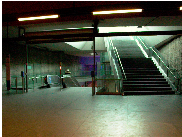
III. 5.1.5 Sydlig trappeforbindelse Udsyn til perronen spærret af elevator
