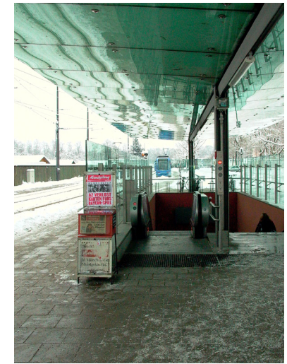
III. 5.1.7 Nordlig trappeforbindelse gadeniveau
