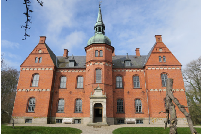
Skovsgårds hovedbygning ligger centralt i anlægget omgivet af vandgrave
