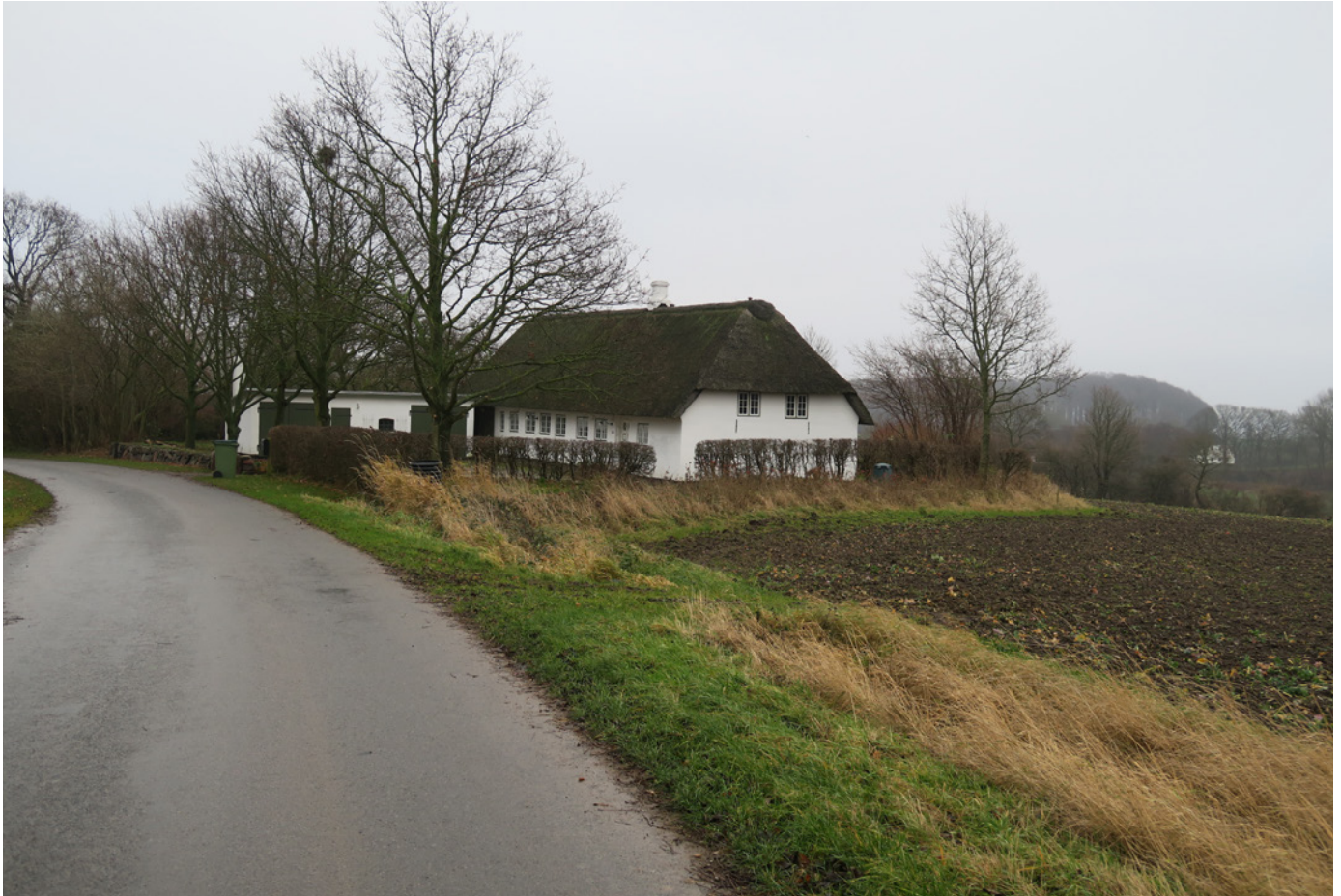
Et karakteristisk, stråttækt hus højt beliggende i det kuperede terræn
