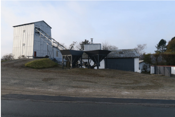
Kalkværket set fra vejen med transportbånd til skaktovnen og kalkpladsen til højre
