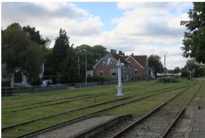
Skinneanlægget med vandkran og enderampe, og funktionærboliger i baggrunden
