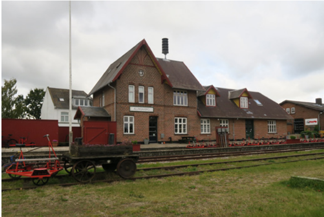
Stationsbygningen med det intakte skinneanlæg i forgrunden og pakhuset i baggrunden
