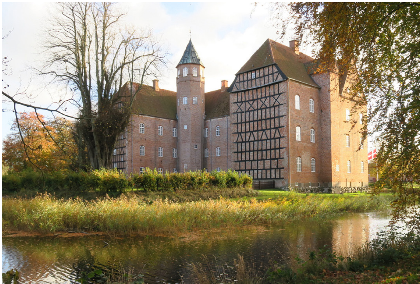
Hovedbygningen med de karakteristiske gavle i bindingsværk omgivet af den vandfyldte voldgrav
