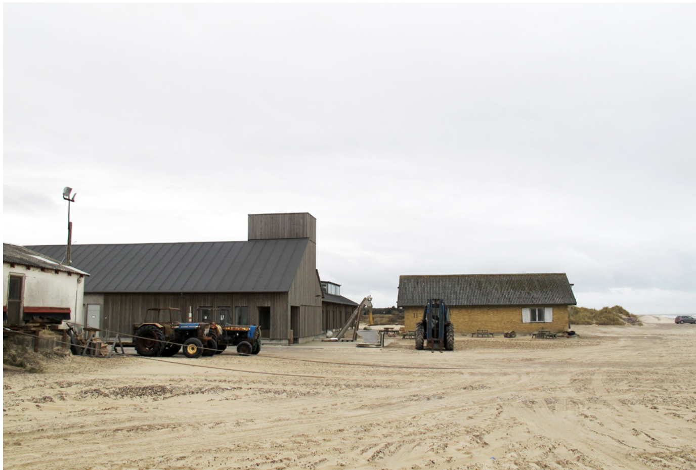
Landingsplads med spilhus og det nye fileteringshus med restaurant og fiskeforretning
