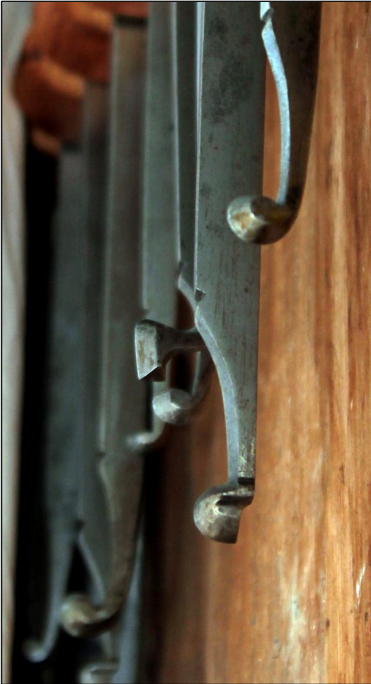
Fig. 150: Drejehjern, detalje vægpanelerne
