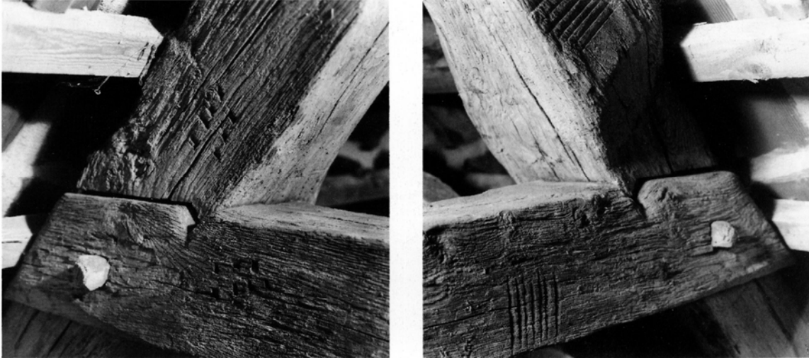
Fig. 8. Detaljer fra tagværket. Samlingerne mellem hanebånd og spær i skibets syvende fag, set fra vest (s. 3132). Ole Nielsen fot. 1979. - Details of the roof construction. The joining of collar beams and rafters in the seventh bay over the nave.
