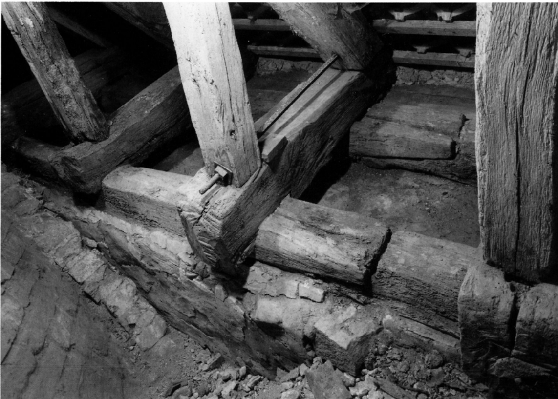
Fig. 9. Udsnit af murkronen, murremmene og tagværksfoden i skibets nordside, set fra øst. Til venstre lille parti af hvælvet (s. 3132). Ole Nielsen fot. 1979. - Detail of the crown of the wall, wall plates, and lower roof structure on the north side of the nave.
